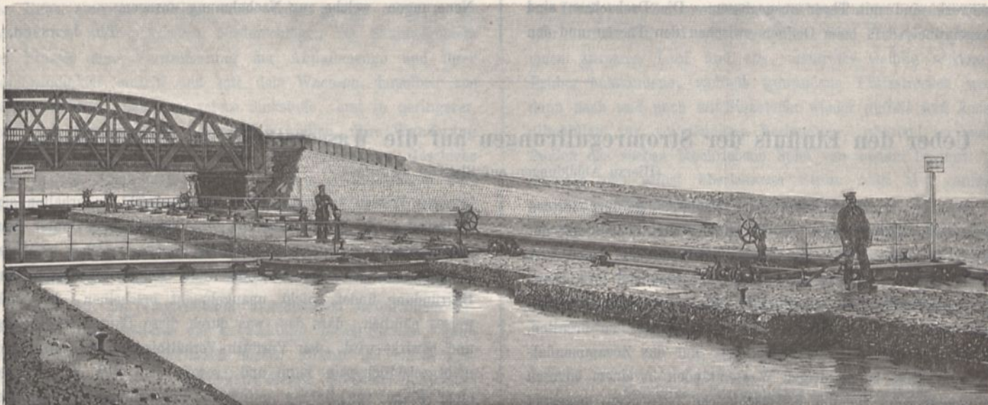
Aufsicht auf die Mittelmauer der Schiffahrtsschleusen am Canal St. Denis.
