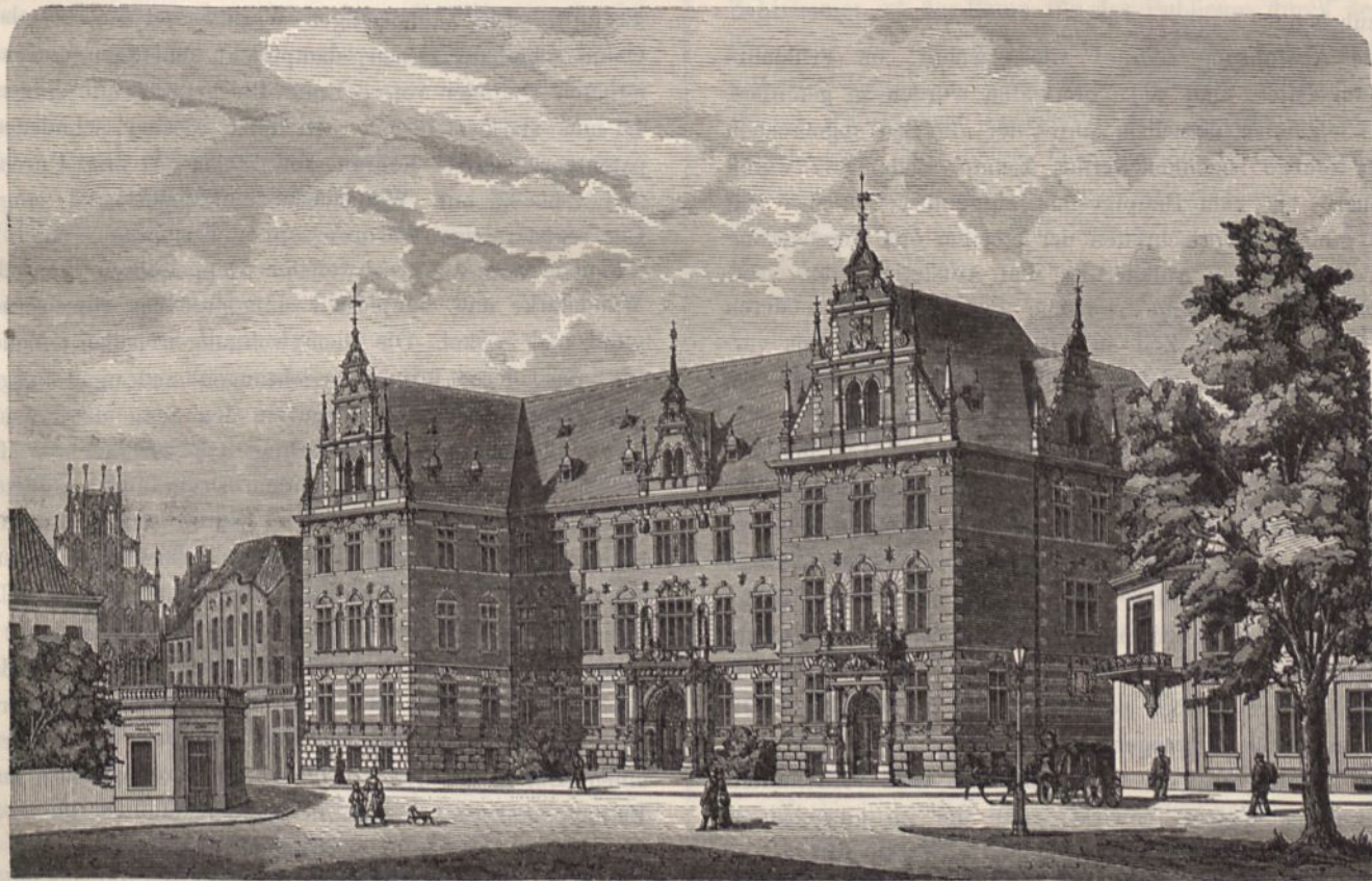
Regierungsgebäude in Münster. Ansicht vom Michaelis-Platz.
