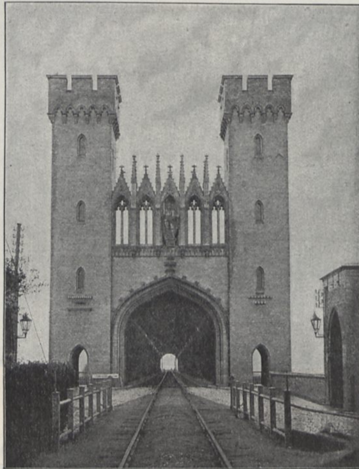
Abb. 4. Ostportal der alten Nogatbrücke bei Marienburg.
