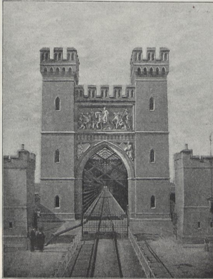
Abb. 1. Ostportal der alten Weichselbrücke bei Dirschau.
