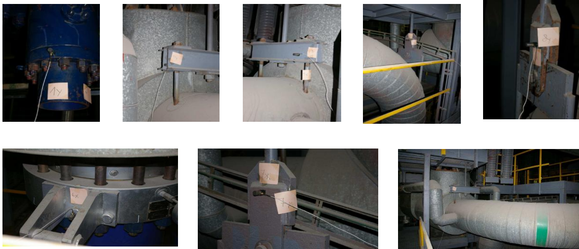
Rys. 11.37. Rzeczywiste umiejscowienie czujników pomiarowych
