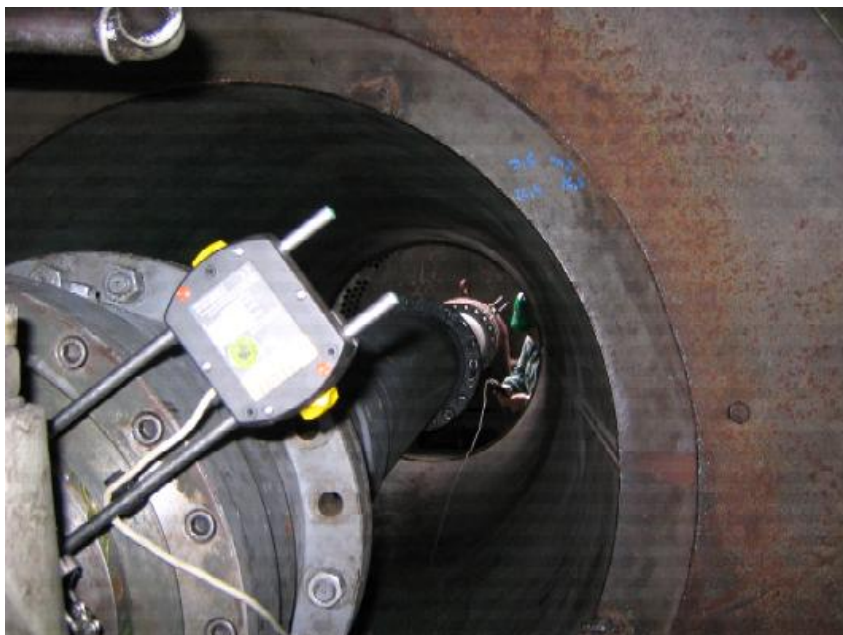
Rys. 10.14. Wentylator spalin z wałem pośrednim w trakcie laserowego osiowania
