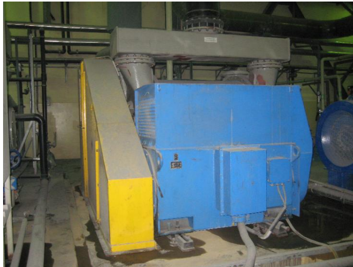
Rys. 11.15. Widok napędu pompy próżniowej
