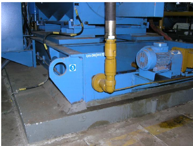
Rys. 11.29. Fundament wraz z płytą posadowczą silnika sprężarki
