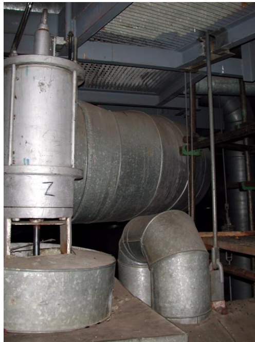
Rys. 11.45. Prawa klapa zwrotna z ciągnem mocującym po wycięciu belek podestu
