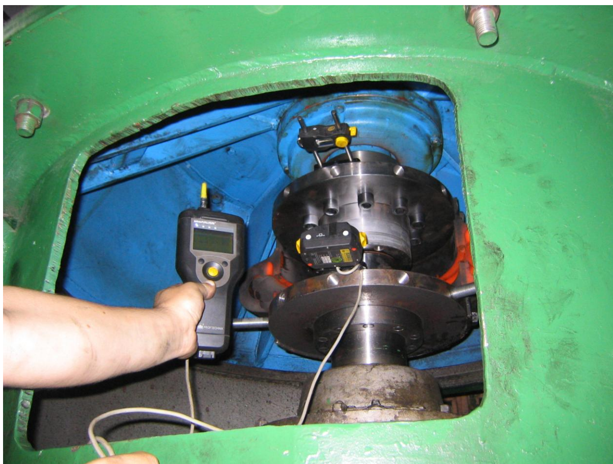
Rys. 10.13. Widok ogólny osiowania wałów na sprzęgle pompy posadowionej pionowo
