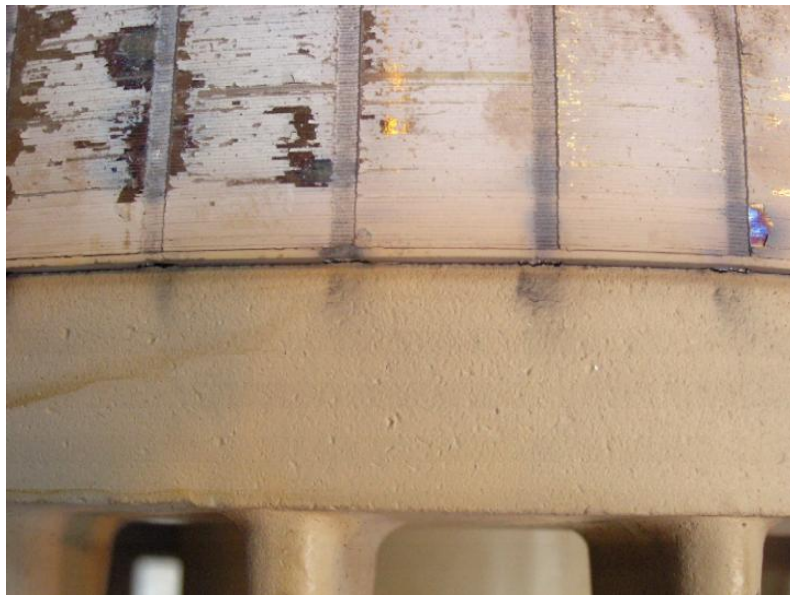
Rys. 11.19. Pęknięcia klatki wirnika
