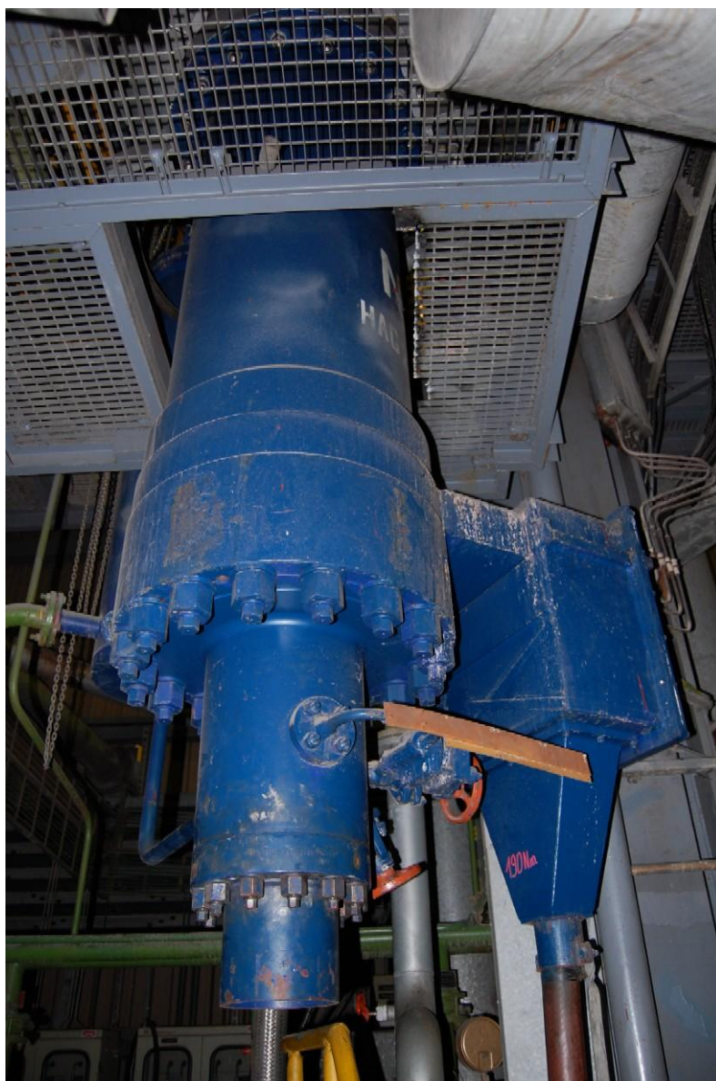
Rys. 11.30. Widok zespołu pompy cyrkulacyjnej NK
