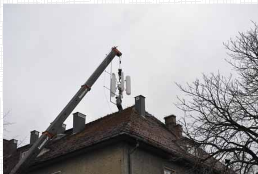
Nowoczesna minielektrownia wiatrowa, dzięki której prof. Boczar będzie badał infradźwięki jest już zamontowana na dachu budynku n 2 w II kampusie.
