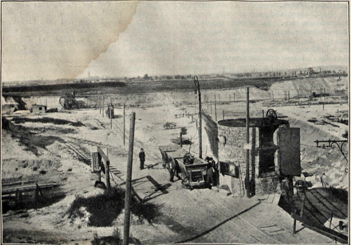
Sandgewinnung und -Verstärkung auf der Myslowitzgrube (Oberschlesien).
