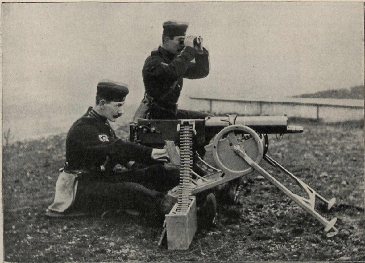
Die Schlittenlafette in erhöhter Stellung.
