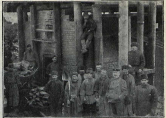
Bau eines Meilerofens.
