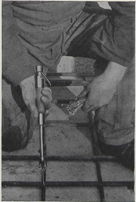
Zusammenbinden der Eiseneinlagen einer Eisenbetondecke.
