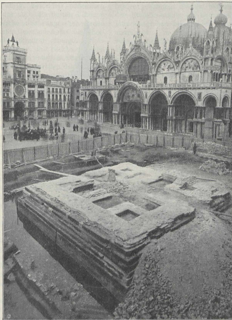
Die Fundamente des Campanile.
