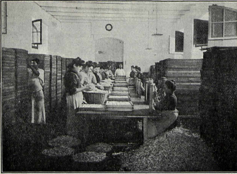
Enfleuranceprozeß in Südfrankreich. Beschicken (links) und Entleeren (rechts) der Châssis.
