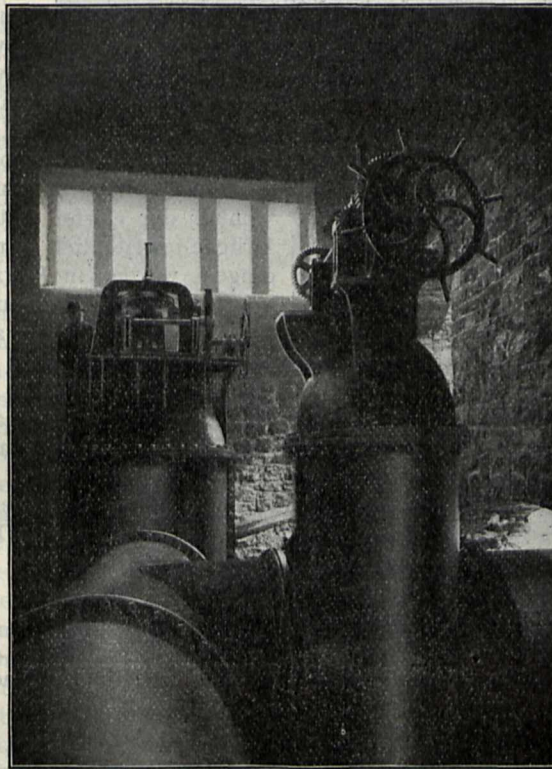
Inneres eines Schieberhauses. (Schieber von 140 cm l. W.).
