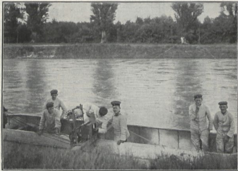
Aufnahme eines Flußprofils.
