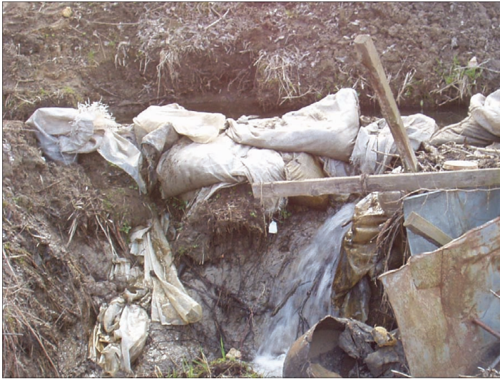
Fot. 5. Nielegalna zabudowa koryta Mielnicy przypadkowym materiałem (fot. Sz. Szewrański) Phot. 5. Illegal damming construction in Milenica stream bed
