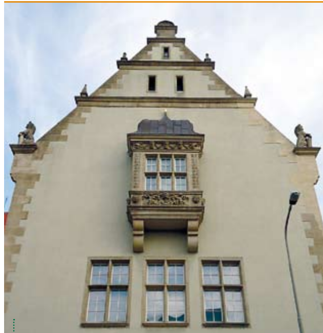
Nowsza (południowa) część Gmachu Głównego – zachodnia ściana szczytowa
