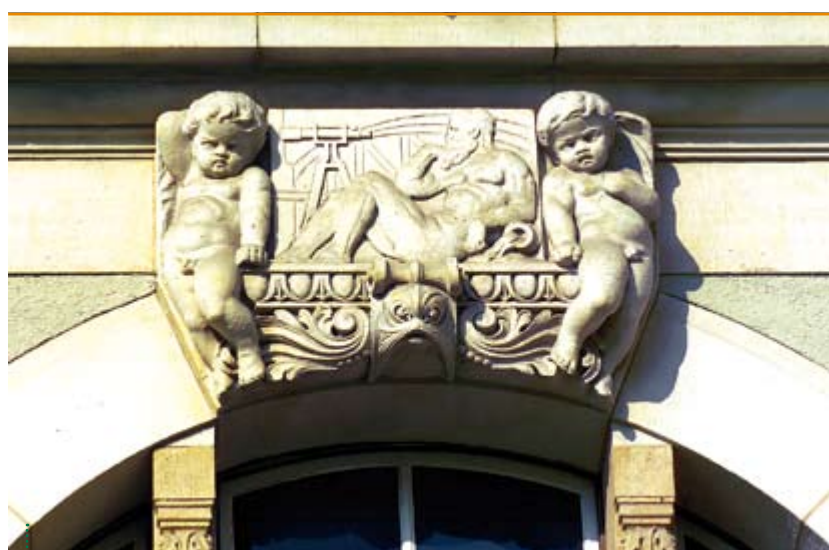
Zwornik wschodniego okna holu parteru
