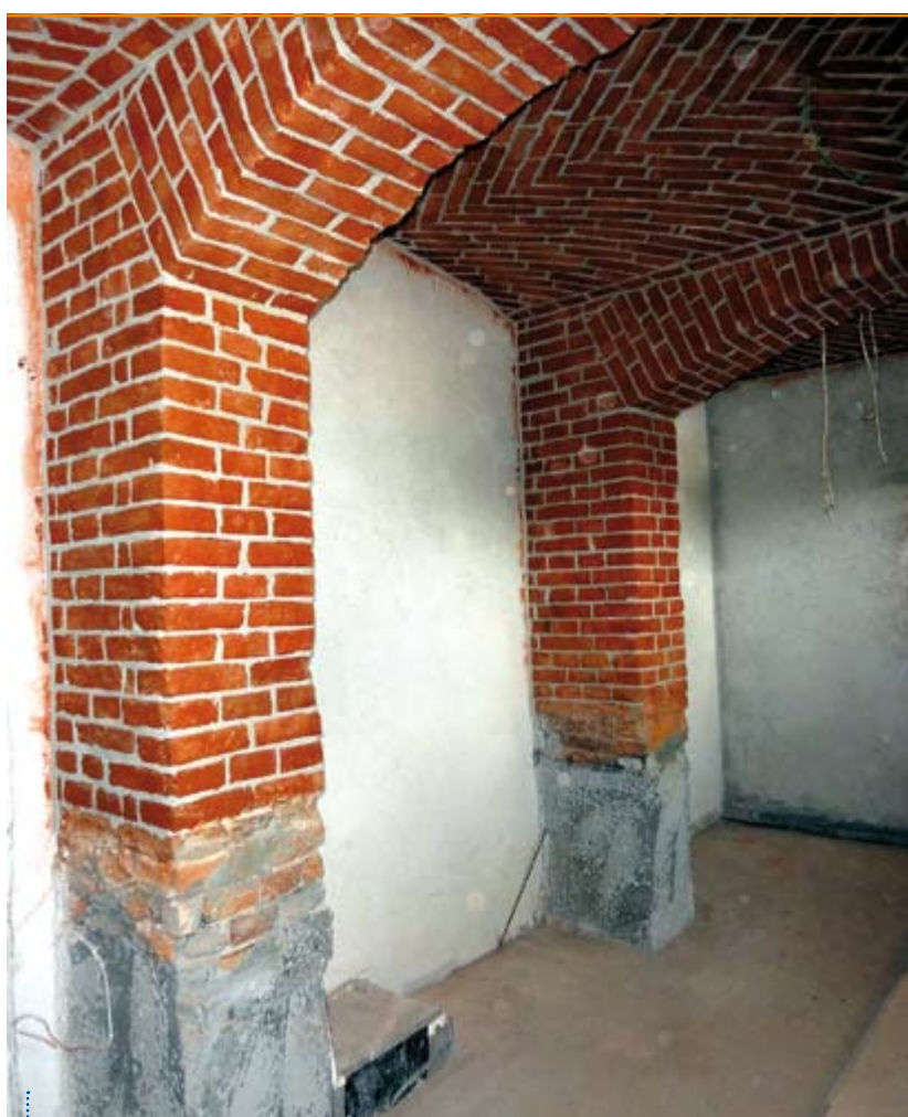
Piwnice po pogłębieniu
