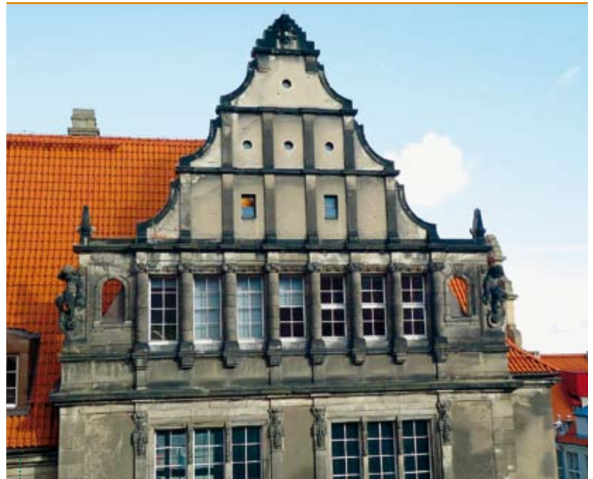
Południowa elewacja skrzydła wschodniego
