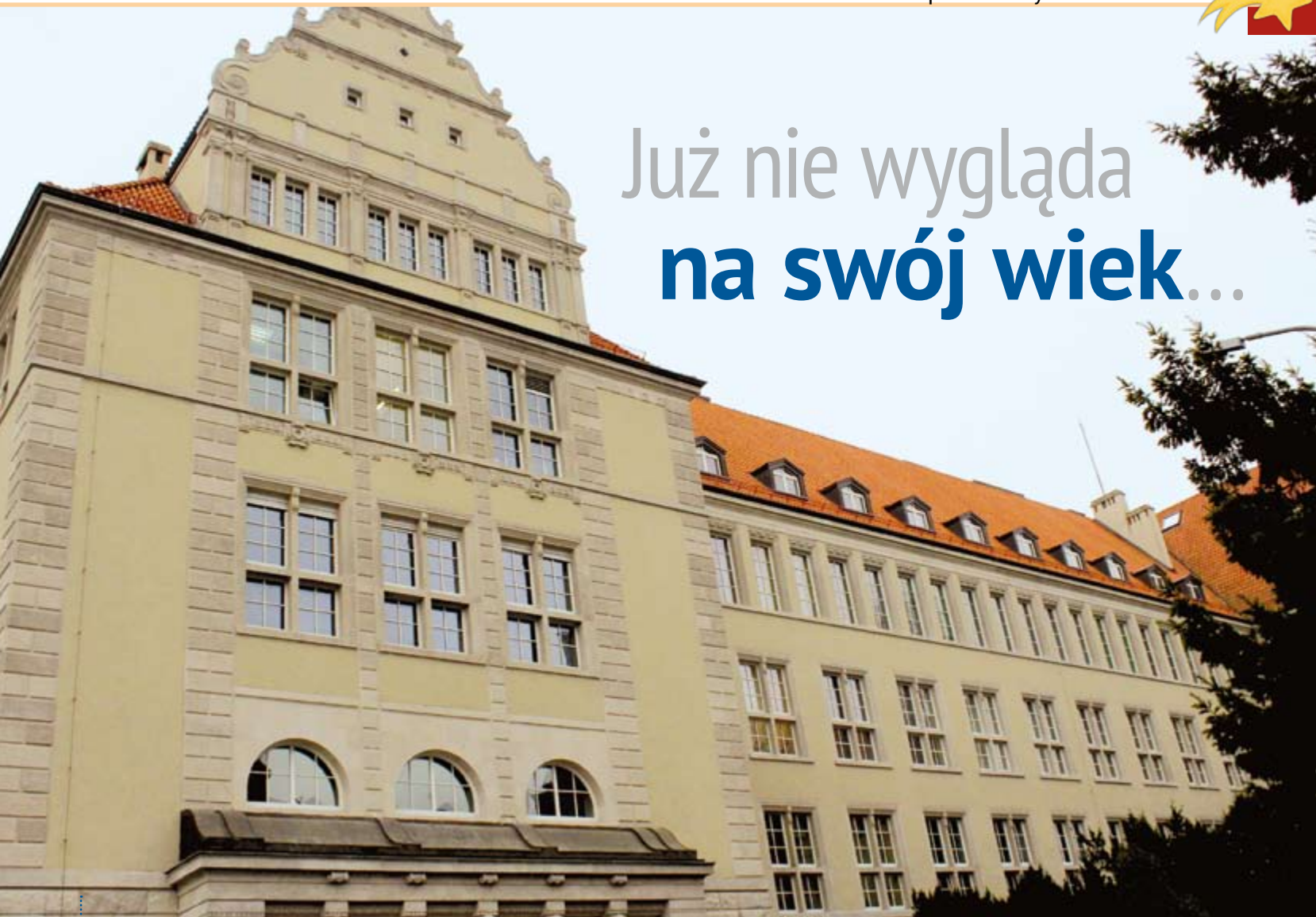
Ściana budynku od ul. Łukasiewicza
