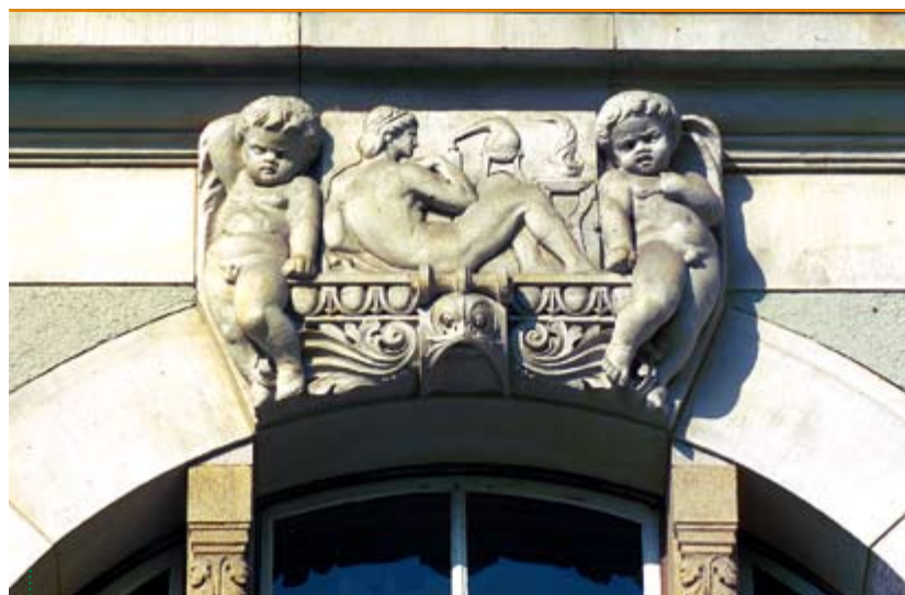
Zwornik zachodniego okna holu parteru
