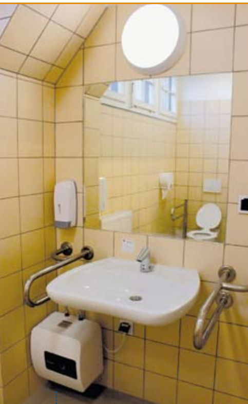
Toalety przystosowano dla osób niepełnosprawnych
