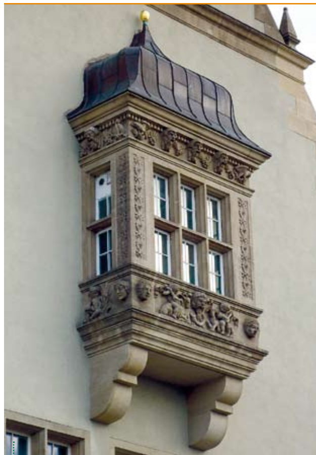
Wykusz zachodniej ściany szczytowej
