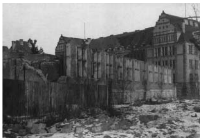
Zniszczony gmach Nowej Chemii (A-2) od strony Wybrzeża Wyspiańskiego (dawna Uferzeile)
