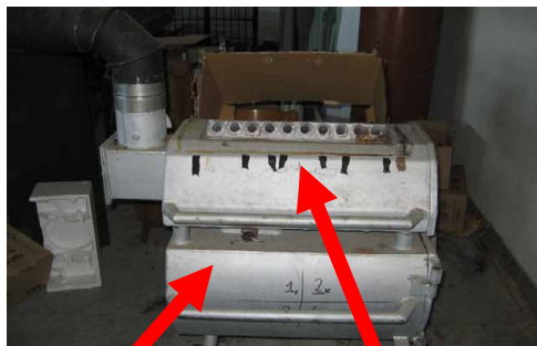
Część paleniskowa. Furnace part Widok nagrzewnicy View of heater
