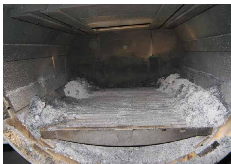
Wnętrze komory spalania po zainstalowaniu rusztów Combustion chamber after installing the grid
