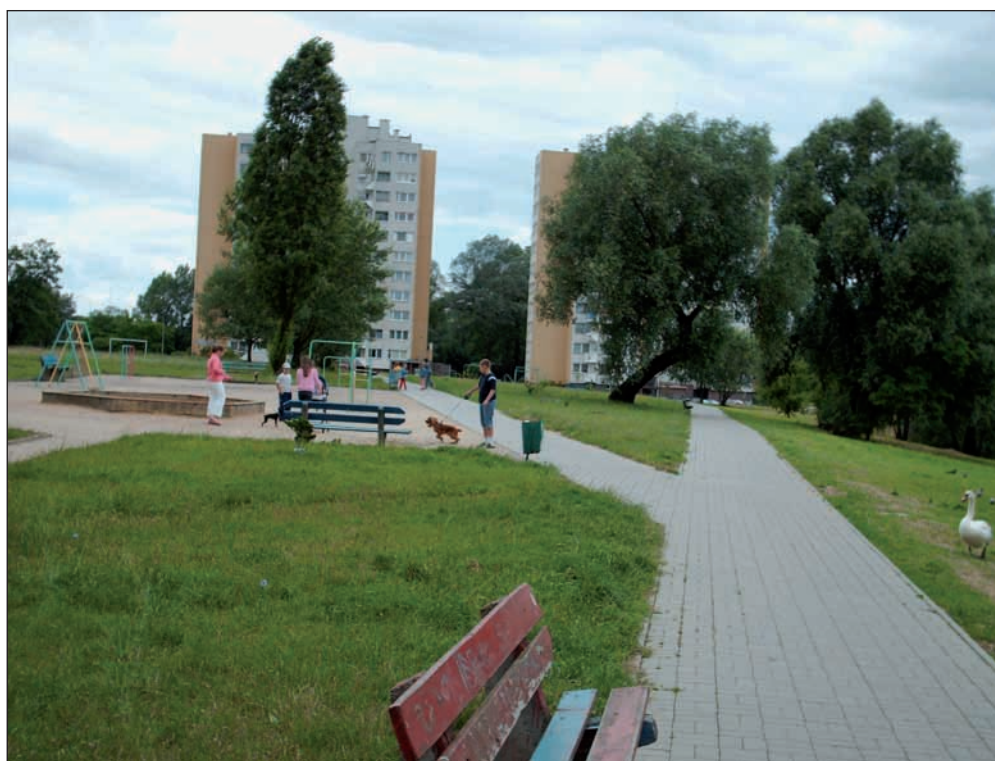
Fot. 14. Osiedle Pilczyce. Rozległe wnętrze pomiędzy zabudową z palcem zabaw często użytkowanym niezgodnie z przeznaczeniem
