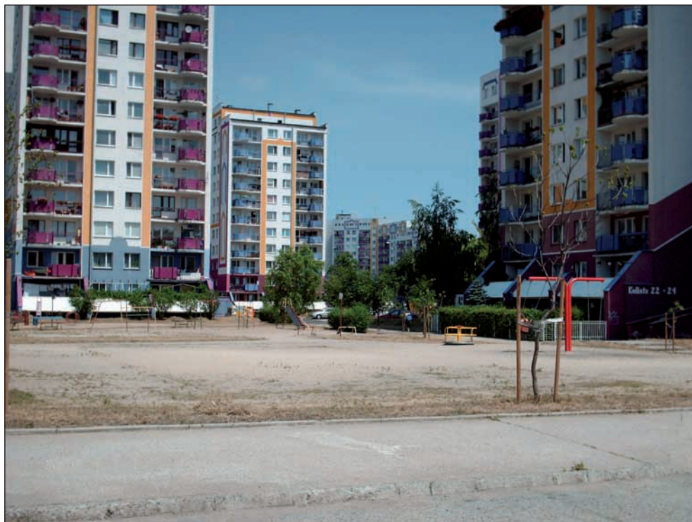
Fot. 13. Osiedle Kozanów, zespół przy ul. Kolistej. Przestrzeń między budynkami rzadko użytkowana Photo. 13. Kozanów estate, complex at Kolista str. Space between the buildings is rarely used
