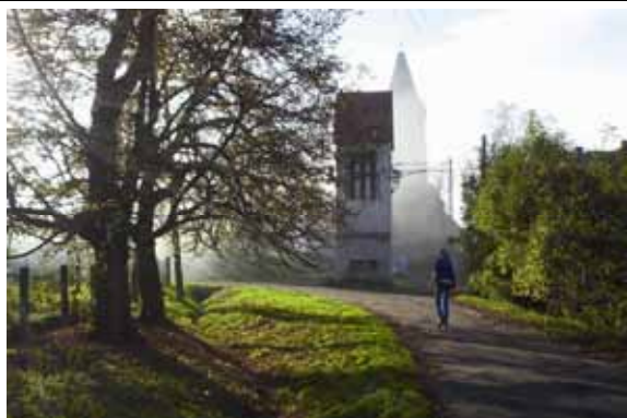
Ryc. 5.152. Stacja transformatorowa wieżowa we wsi Brzezina (gmina Skarbimierz), 2005 Fig. 5.152. A transformer tower station in Brzezina village (Skarbimierz commune), 2005
