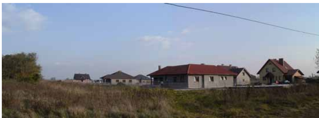
Ryc. 5.133. Nowe osiedle domów jednorodzinnych o zróżnicowanych formach i kolorystyce dachów, wieś podmiejska Krzyków (gmina Czernica), 2007 Fig. 5.133. A new estate of one family houses with various forms and roof colour, Krzyków (Czernica commune), 2007
