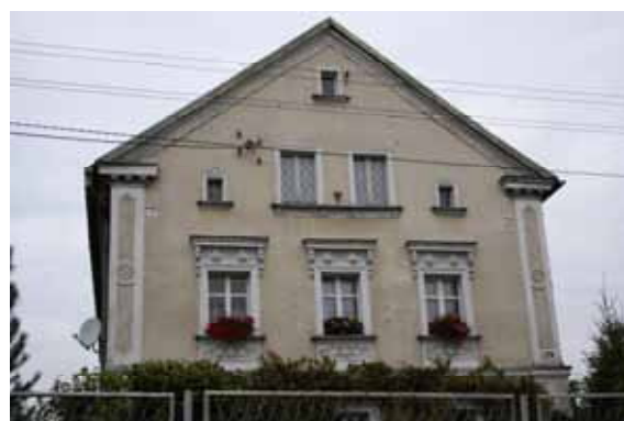
Ryc. 5.137. Zdobnictwo nawiązujące do form klasycystycznych. Ściana szczytowa budynku mieszkalnego, Złotogłowie (gmina Nysa), 2008
