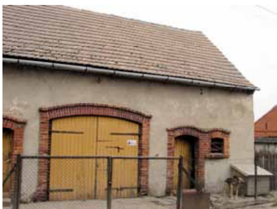
Ryc. 5.140. Ceglane obramienia otworów okiennych i wrot w stodole, Ślęza (gmina Kobierzyce), 2005 Fig. 5.140. Brick framing of window openings and barn doors, Ślęza (Kobierzyce commune), 2005
