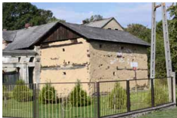
Ryc. 5.56. Jeden z dwóch zachowanych spichlerzy we wsi, 2001 Fig. 5.56. One of the two preserved granaries in the village, 2001
