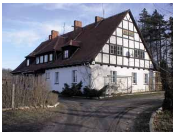
Ryc. 5.135. Ekspozycja drewnianych elementów konstrukcji ryglowej w elewacji, Ostaszów (gmina Przemków), 2008 Fig. 5.135. Exposition of wooden elements of interlocking construction in Ostaszów (Przemków commune), 2008
