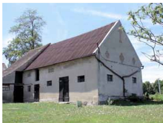
Ryc. 5.141. Otwory wentylacyjne w formach geometrycznych i symbolu chrześcijańskiego (krzyż w szczycie budynku), Kozielno (gmina Paczków), 2007 Fig. 5.141. Ventilation openings in geometrical forms and Christian symbol (a cross in the top on a building) Kozielno (Paczków commune), 2007
