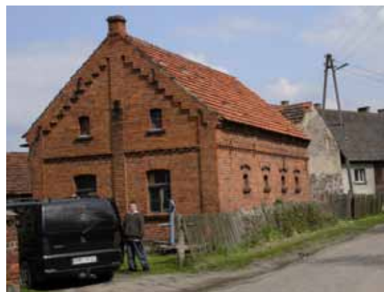
Ryc. 5.139. Ściana szczytowa w budynku licowanym cegłą, Pracze (gmina Milicz), 2008
