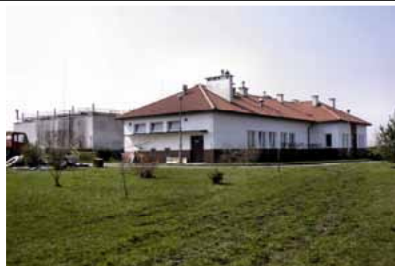
Ryc. 5.153. Oczyszczalnia ścieków, Strzeszów (gmina Wisznia Mała), 2008 Fig. 5.153. A sewage treatment plant, Strzeszów (Wisznia Mała commune)
