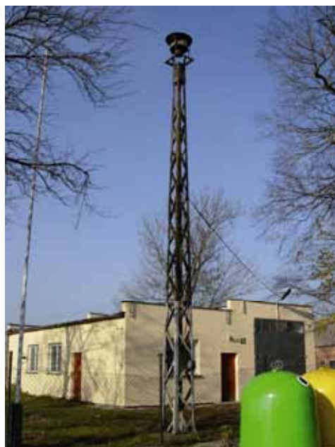
Ryc. 5.85. Metalowy słup z syreną alarmową przy remizie w Piecowicach (gmina Długoleka), 2005
