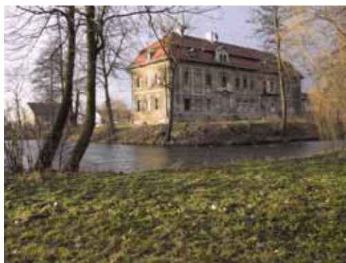
Ryc. 5.200. Fosa wokół pałacu w Strzeszowie (gmina Wisznia Mała), 2002 Fig. 5.200. A moat around a park in Strzeszów (Wisznia Mała commune), 2002
