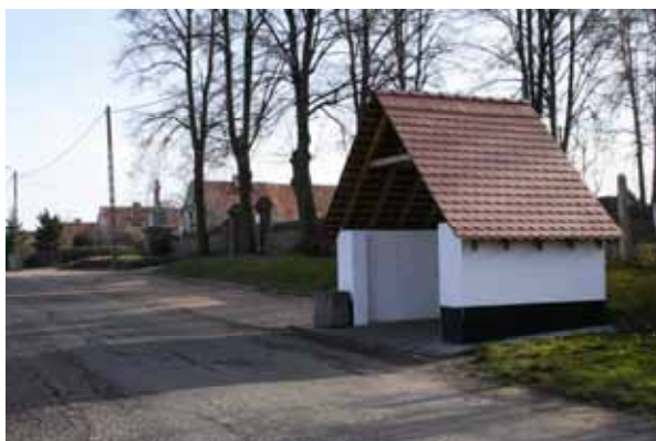
Ryc. 5.150. Przystanek autobusowy dopasowany do zabudowy pozostałej części ulicy we wsi Kozielno (gmina Paczków), 2007 Fig. 5.150. A bus stop adjusted to the development of the rest of the street in Kozielno village (Paczków commune), 2007
