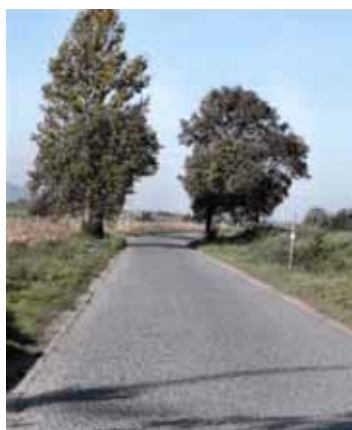
Ryc. 5.187. Brama wjazdowa do wsi Tyniec nad Ślężą (gmina Kobierzyce), 2006 Fig. 5.187. An entrance gate to Tyniec village upon Ślęża river (Kobierzyce commune), 2006
