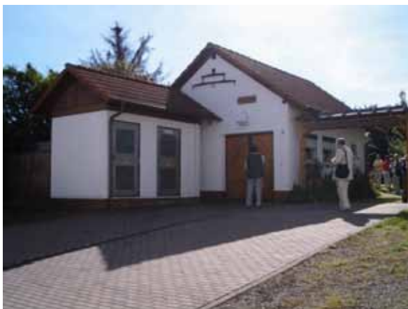
Ryc. 2.21. Trafostacja we wsi Konken, 2004 Fig. 2.21. Power transformer station in Konken village, 2004
