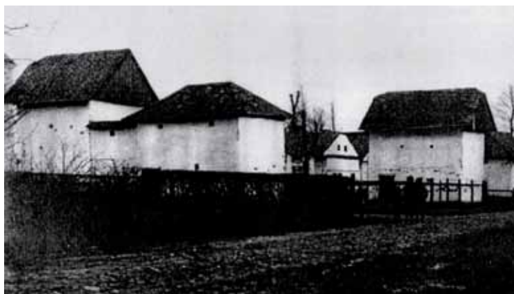
Ryc. 5.54. Spichlerze w przedogródkach, początek XX wieku Fig. 5.54. Granaries in the front garden, state from the beginning of the 20th century
