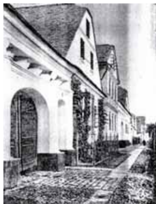
Ryc. 5.14. Chodnik pomiędzy zwartą pierzeją budynków połączonych bramami a przedogrodkiem, lata międzywojenne
