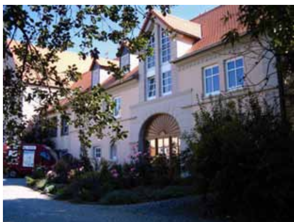
Ryc. 2.1. Adaptacja stodoły na budynek mieszkalny, Konken, 2004 Fig. 2.1. A barn adaptation into a residential building, Konken, 2004
