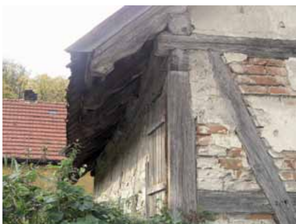
Ryc. 5.134. Ozdobne zakończenie krokwi w budynku gospodarczym, Kątna (gmina Długoleka), 2005 Fig. 5.134. Decorative finish of rafters in a farming building, Kątna (Długoleka commune), 2005
