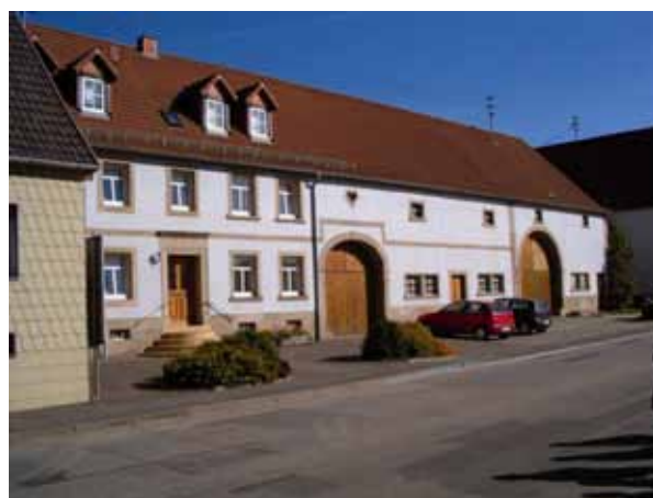
Ryc. 2.2. Adaptacja budynku zespolonego na budynek mieszkalny, Konken, 2004 Fig. 2.2. Compound building adaptation into a residential building, Konken, 2004
