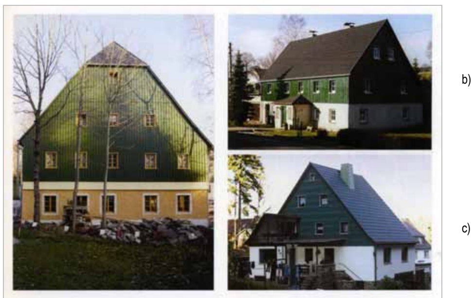
Ryc. 2.15. Przykłady zastosowania kolorystyki elewacji nawiązującej do kolorów ziemi: a) ciepłe barwy kondygnacji przyziemia i piętra, b) i c) zbyt duży kontrast pomiędzy zimnym odcieniem zieleni na piętrze i bielą parteru Fig. 2.15. Examples of using colours on elevations connected to earth: a) warm colours on ground floor and first floor, b) and c) too obvious contrast between a cold shade of green on the first floor and white on the ground floor
