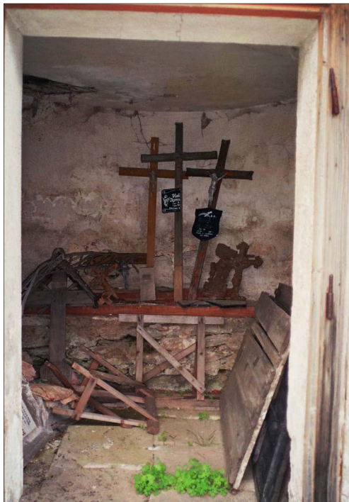
Fot. 44. Lesica – wnętrze zdewastowanej kostnicy (fot. A. Grochowska) Photo 44. Lesica – interior of the devastated morgue
