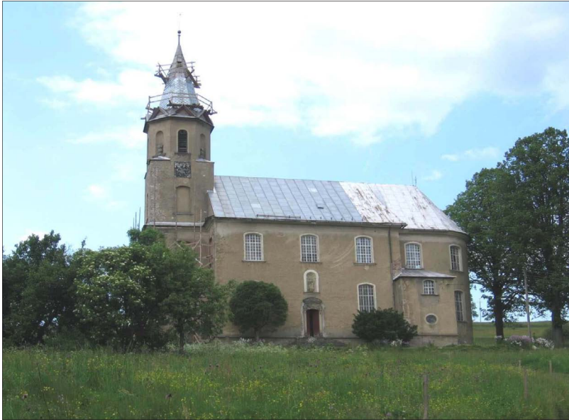
Fot. 4. Kościół w Lesicy w trakcie remontu (fot. A. Krzemińska) Photo 4. Church in Lesica during renovation works
