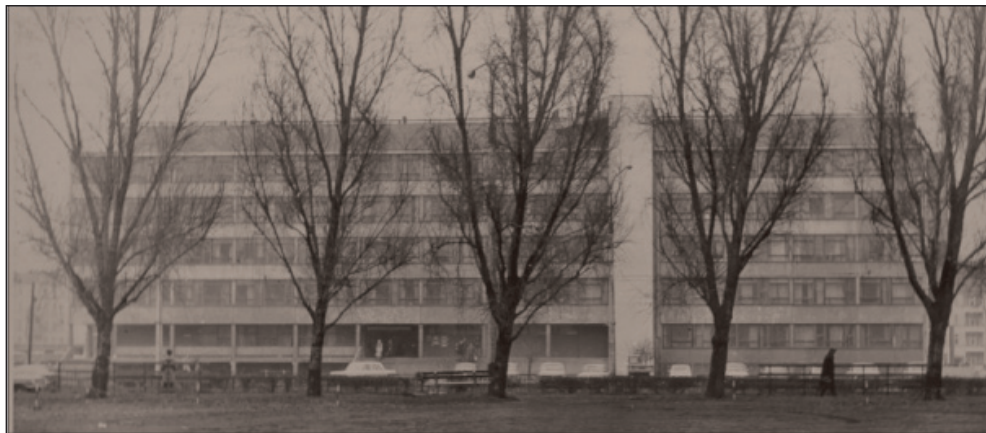
Nowy gmach Wydziału Melioracji Wodnych i Oddziału Geodezji Urzędzeń Rolnych (1970)
