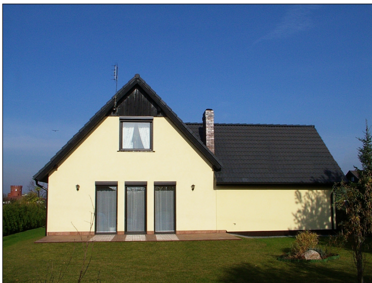
Fot. 4. Widok budynku przed zainstalowaniem kolektorów
