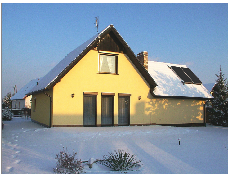
Fot. 5. Widok budynku po zainstalowaniu kolektorów
