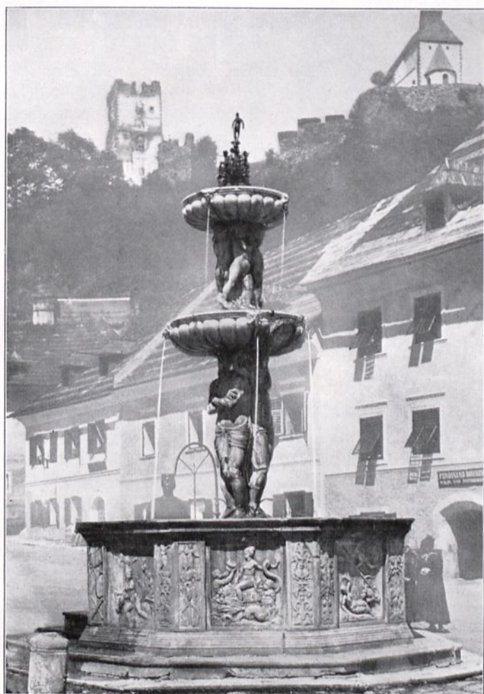
Abb. 145. Friesach i. O., Brunnen. Nach einer Aufnahme von Wlha, Wien.
