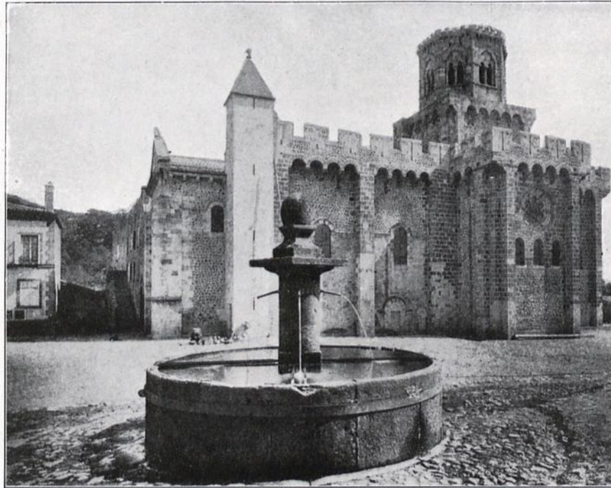
Abb. 170. Noyat (Auvergne), Pfostenbrunnen.
