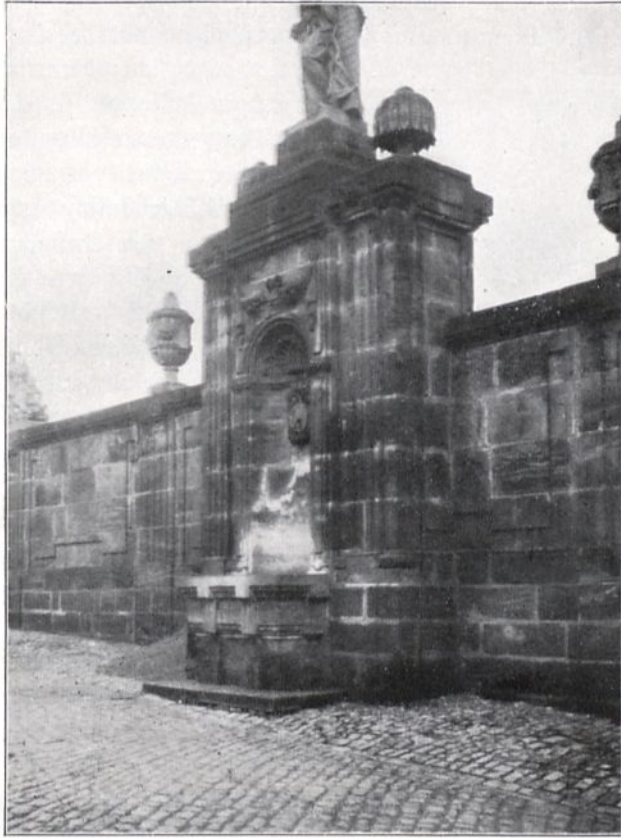
Abb. 173. Bamberg, Wandbrunnen an der Dommauer.
