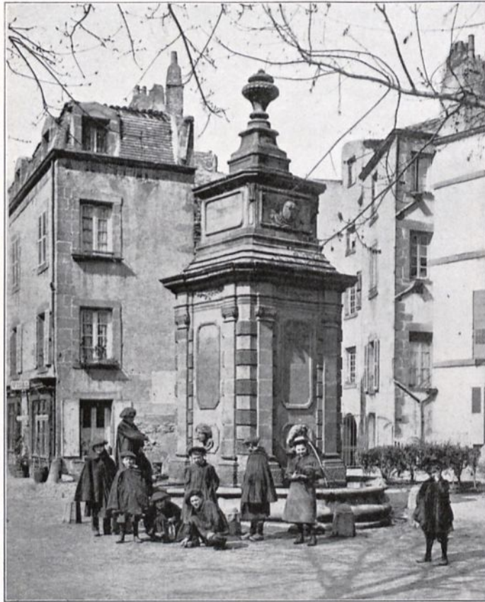
Abb. 161. Rom (Frankreich), Brunnenhaus.
