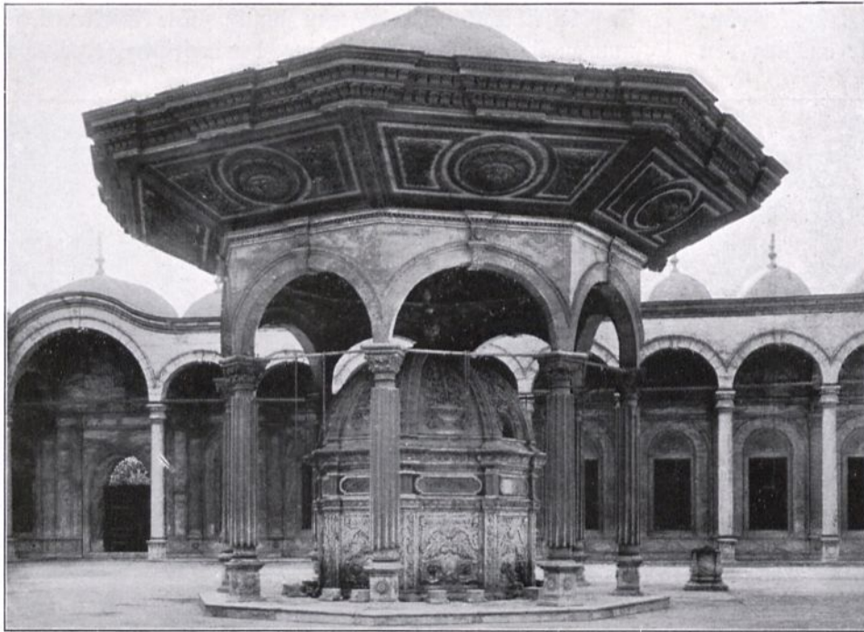
Abb. 200. Kairo, Brunnenhaus der Mehemed Ali-Moschee. Nach einer Aufnahme von Schroeder & Cie., Zürich.
