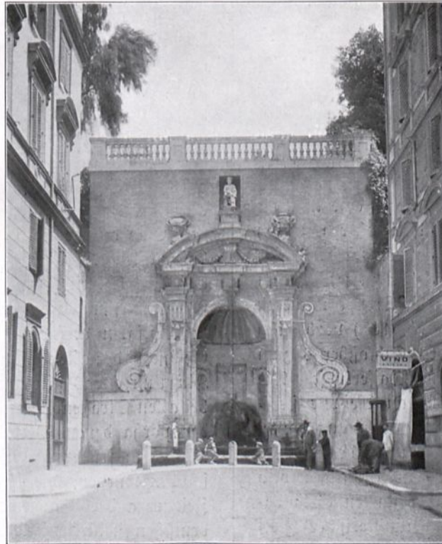
Abb. 227. Rom, Wandbrunnen (umgestellt).
