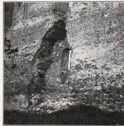
Abb. 5. Rocella: Tür in der nördlichen Umfassungsmauer des Langhauses.
