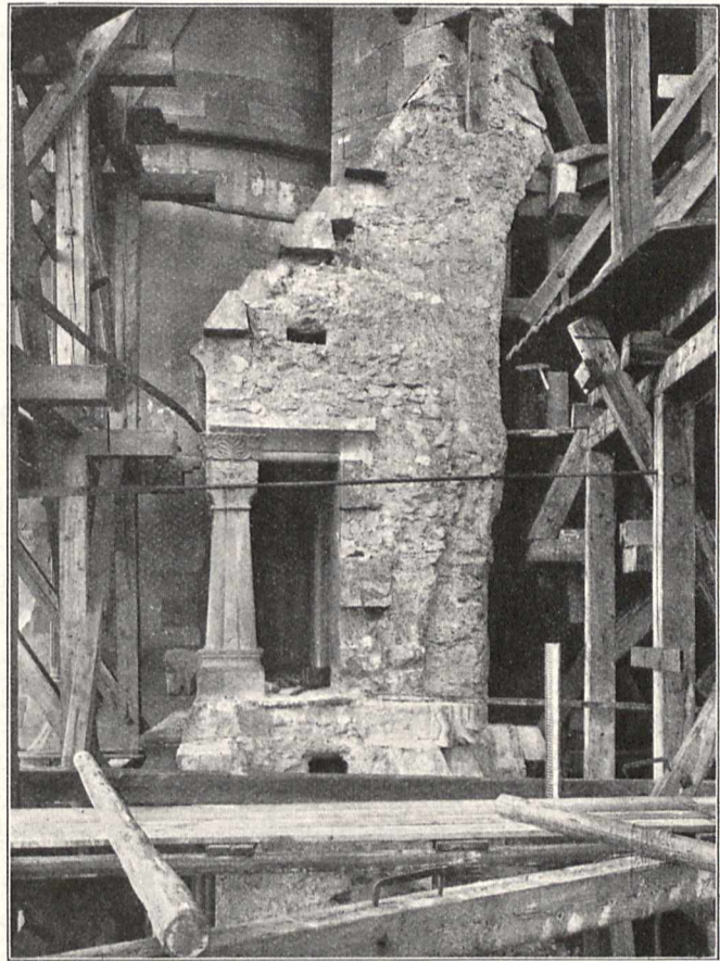
Abb. 17. Nordseite des Chordaches mit den Öffnungen der Holzankerkanäle. Aufnahme vom 11. Juli 1903.
