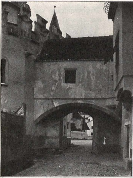
Abb. 17. Verbindungsgang zum alten Spital.
