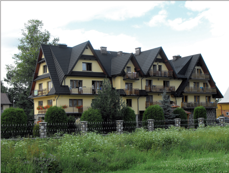
Fot. 7. Widok wielkogabarytowego budynku pensjonatowego we wsi Białka Tatrzańska (fot. autor) Phot. 7. View of a multi-dimensional guest house in Białka Tatrzańska (photograph by author)
