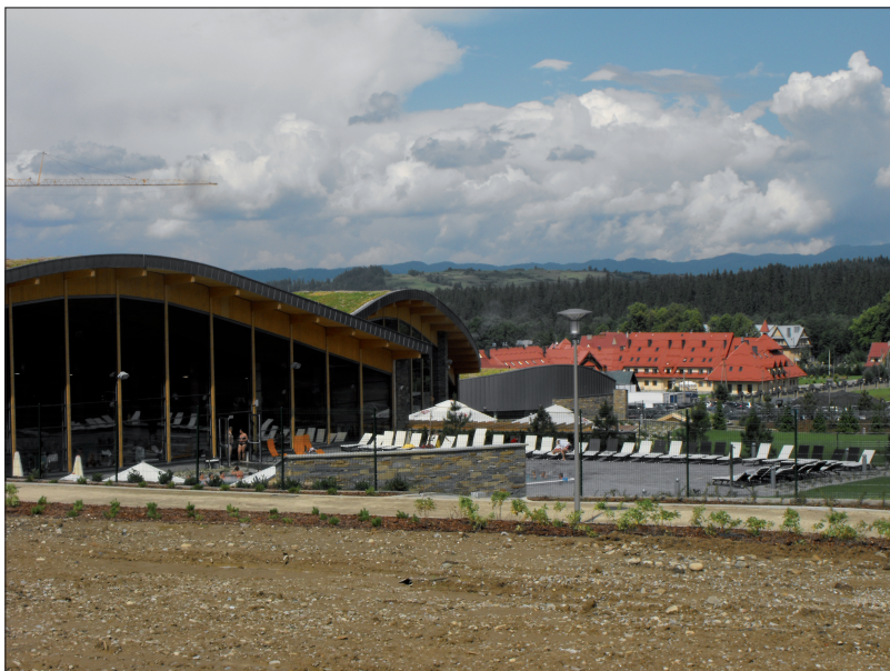
Fot. 14. Widok aquaparku oraz wielkogabarytowego obiektu usługowego w Białce Tatrzańskiej (fot. autor)
