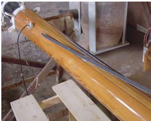
Rys. 3.35. Maszt przygotowany do wklejenia taśm CFRP, [8]
