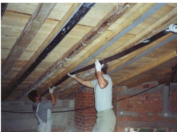
Rys. 3.37. Wzmocnienie krokwi przez doklejenie taśm CFRP, [219]
