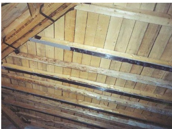
Rys. 3.37. Wzmocnienie krokwi przez doklejenie taśm CFRP, [219]
