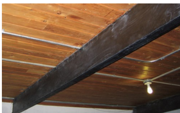
Rys. 3.33. Widok wzmocnionej belki, gimnazjum Coolidge School District, [63]
