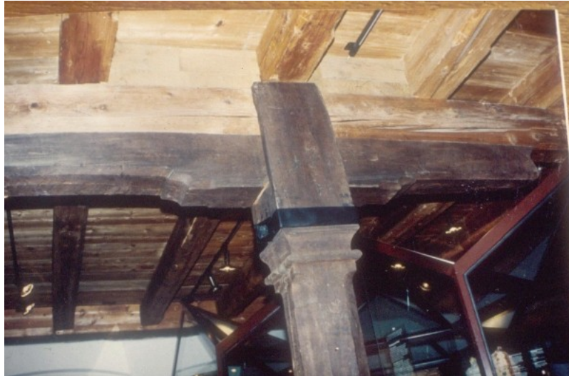
Rys. 3.27. Wzmocniony, opaską z maty CFRP, słup drewniany w obiekcie zabytkowym (Szwajcaria), [224]
