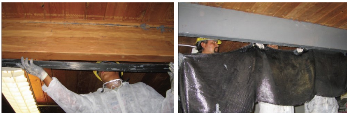
Rys. 3.32. Aplikacja taśmy i maty w budynku gimnazjum Coolidge School District, [63]
