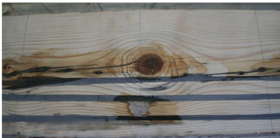
Rys. 4.196. Widok powierzchni belki F2 przed przyklejeniem warstwy powierzchniowej,
