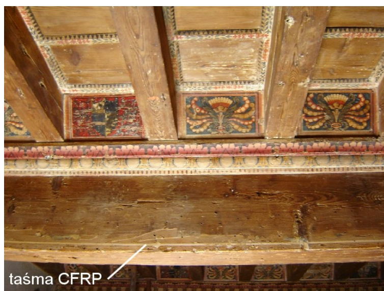
Rys. 3.30. Wzmocnienie belki stropowej w pałacu Nobili (Włochy, 2005), [46]
