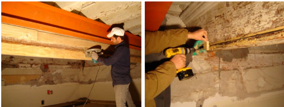
Rys. 3.29. Prace przy wzmocnieniu belek drewnianych w pałacu Nobili (Włochy), [174]
