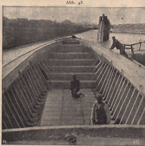
Blick in das Innere der Eisenbetonschute. (Bauart Rüdiger.)
