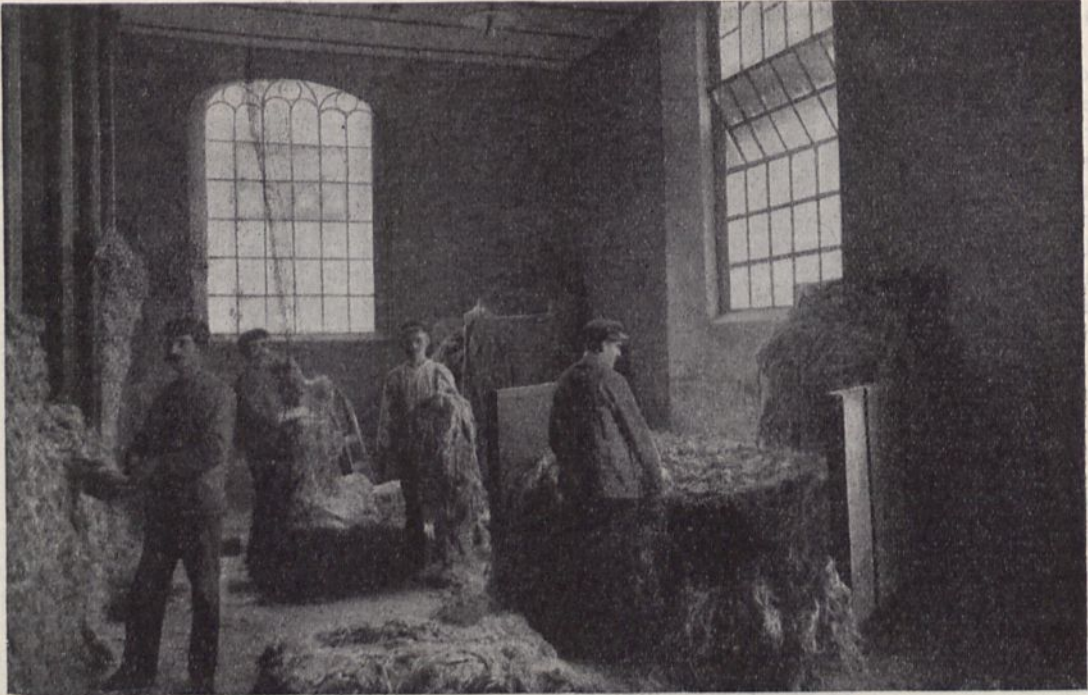
Der sog. Batschraum. Hier werden die Juteballen geöffnet und die einzelnen festgepressten Risten gelockert. (Aus der Jubiläumsschrift der Jutespinnerei und Weberei Bremen.)
