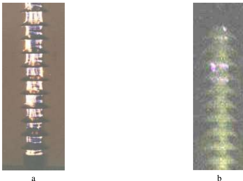
Rys. 6. Wyładowania na zabrudzonych izolatorach [4]
