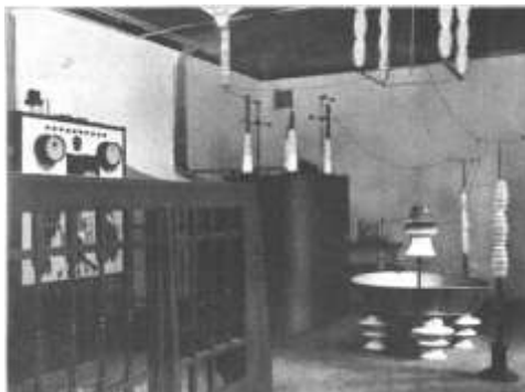
Rys. 2. Najstarsze laboratorium wysokich napięć Politechniki Wrocławskiej w budynku A-5
