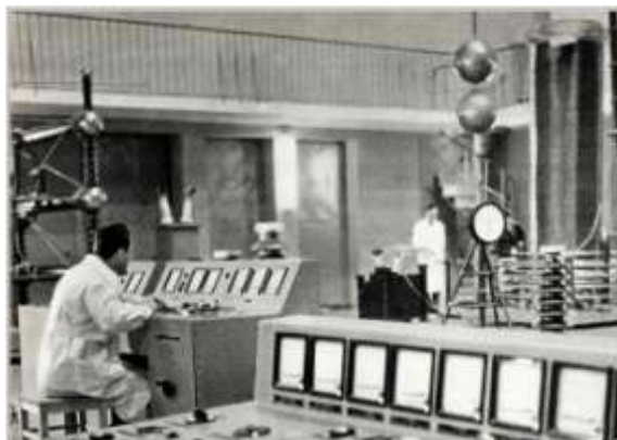
Rys. 4. Generator van der Graaffa (z lewej) i transformator Tesli (z prawej), lata 1960.
