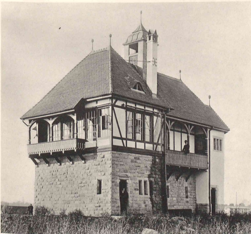
Abb. 2. Fahrdienstturm Nord auf Verschiebebahnhof Hausbergen.
