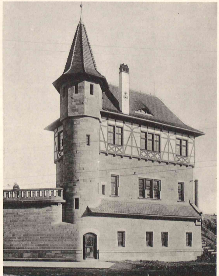
Abb. 3. Stellwerkgebäude auf Bahnhof Straßburg-Neudorf.
