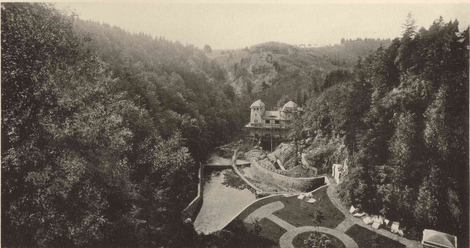
Abb. 3. Elektrizitätswerk und Auslauf der Umlaufstollen.
