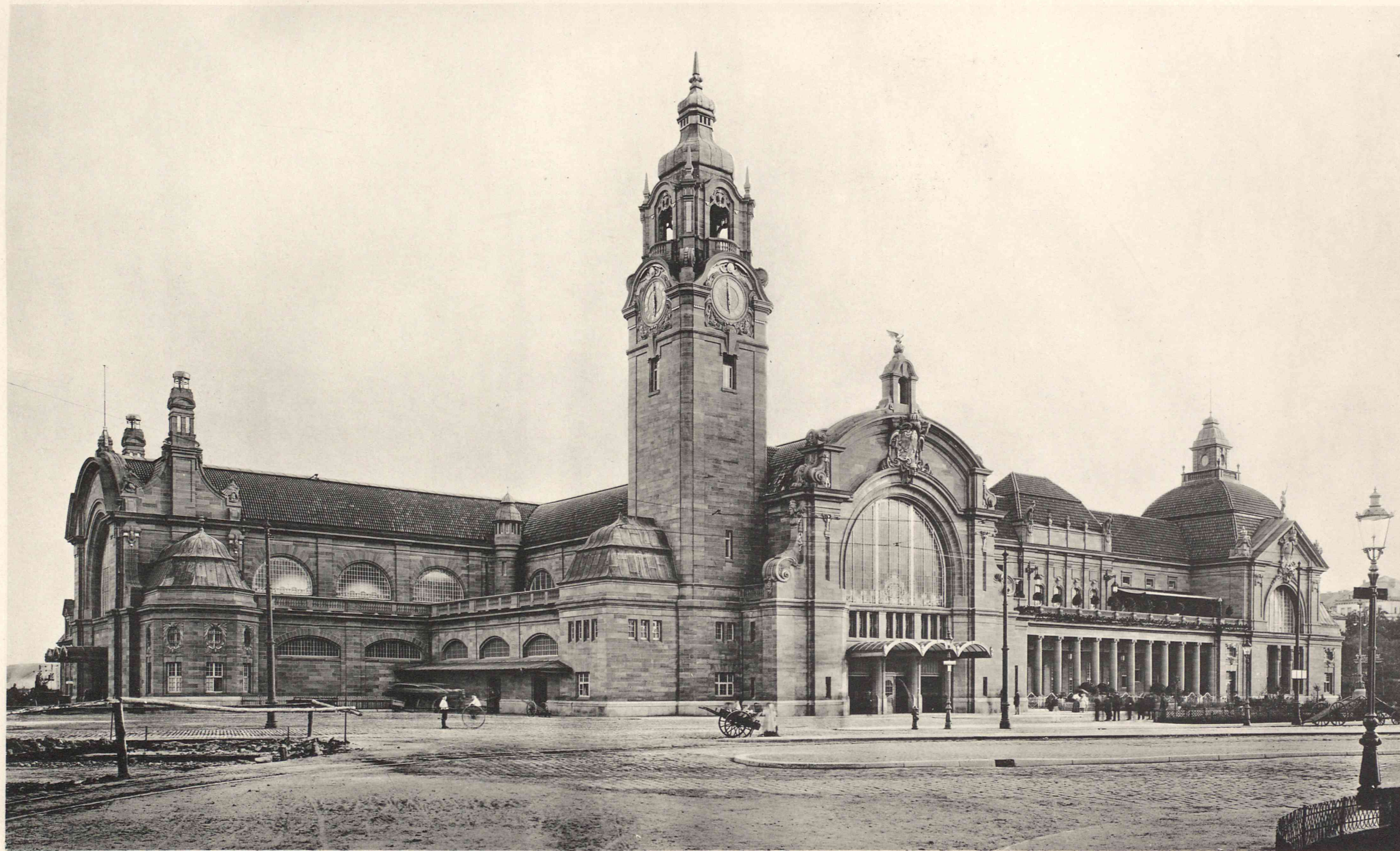
Ansicht von der Kaiserstraße (Nordosten).
