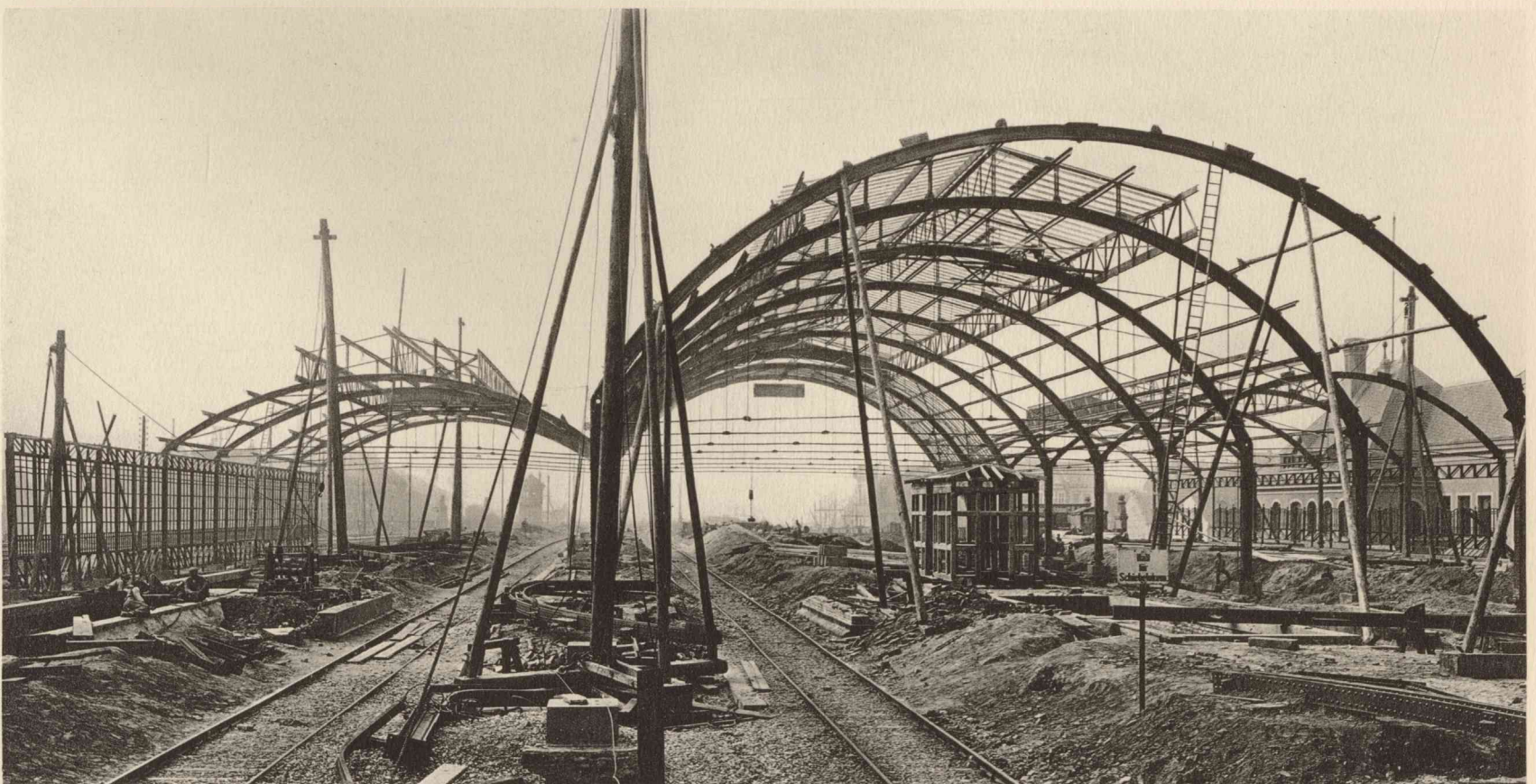
Abb. 3. Aufstellung der Bahnsteighalle. Blick nach Westen.
