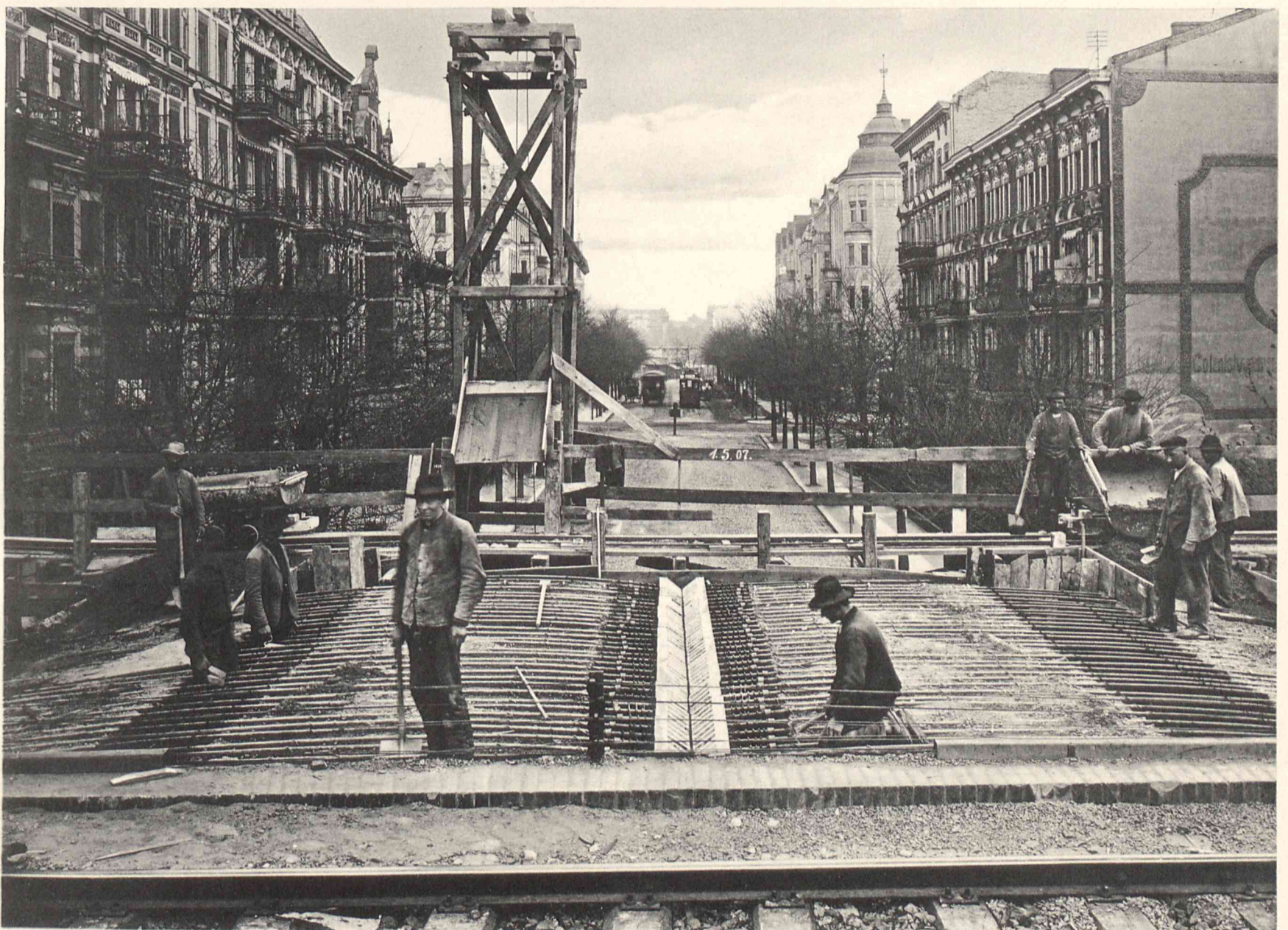
Abb. 2. Eisengerippe während der Betonierung (senkrecht zur Gleisrichtung gesehen).
