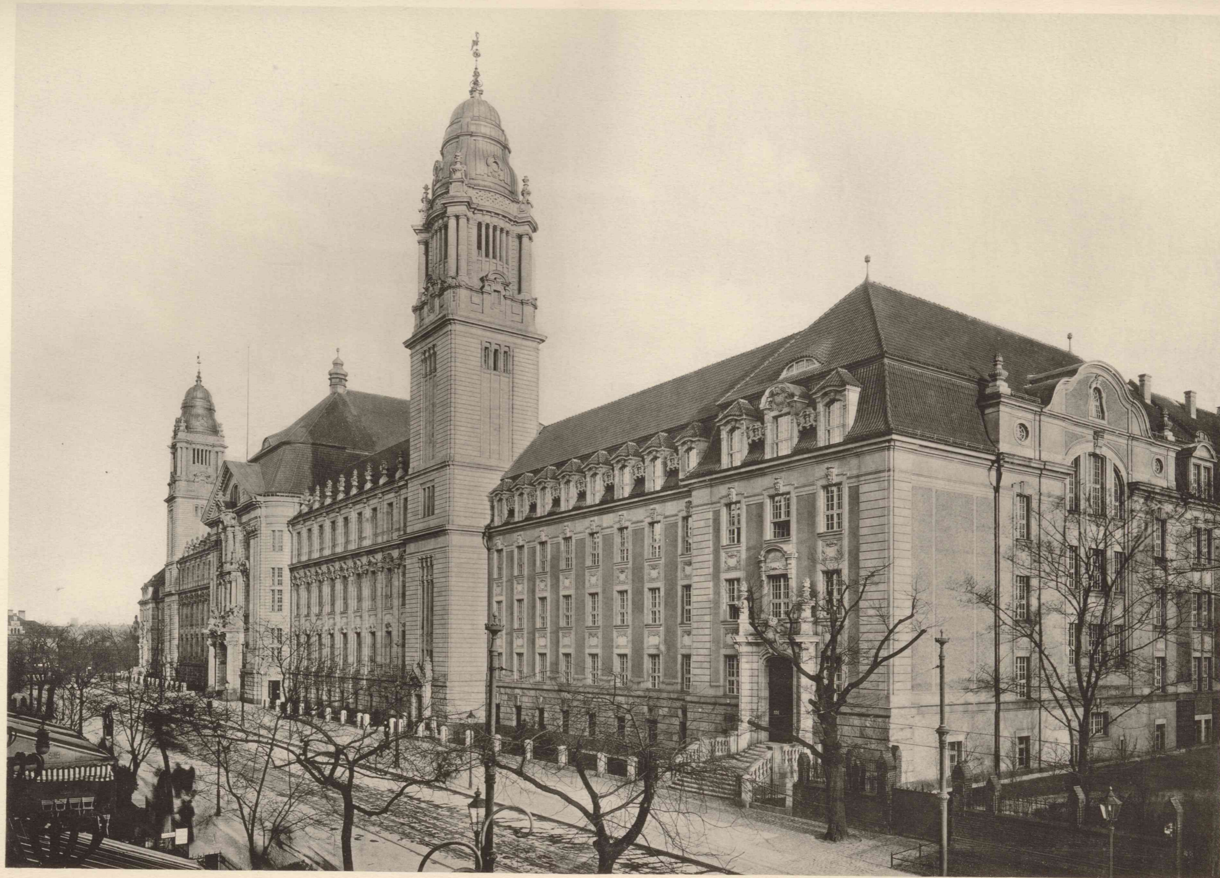
Hauptfront in der Turmstraße.
