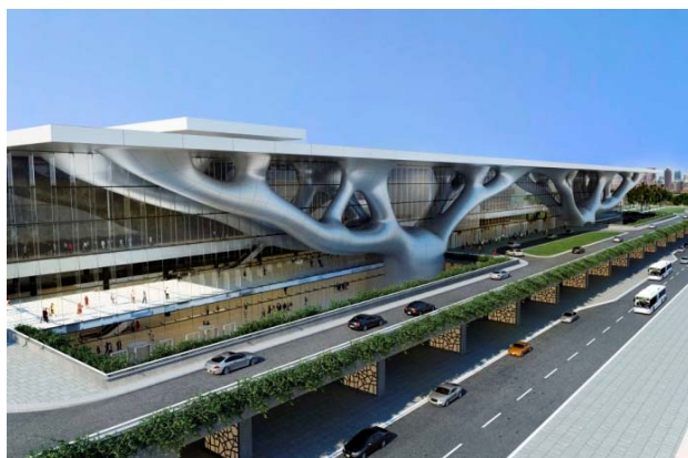
Rys. 7.56. Optymalizacja ewolucyjna konstrukcji o dużej rozpiętości – Education City Convention Centre, Katar (proj. arch. Arta Isozaki, proj. konstr. Mutsuro Sasaki)
