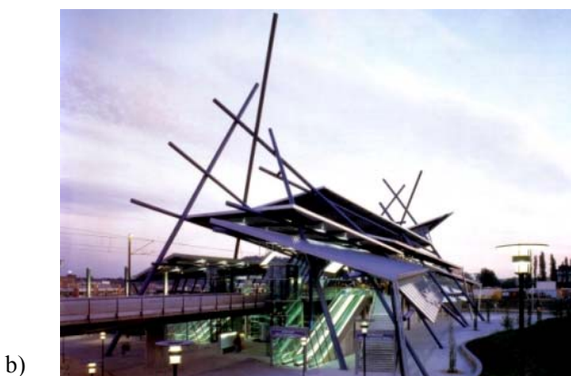
Rys. 6.36. Stacja kolejowa w Oberhausen: a) inspiracja – składowisko złomu, b) widok budynku stacji
