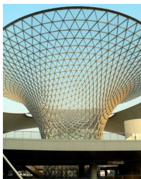
Rys. 7.53. Główna aleja na wystawie EXPO 2010 w Szanghaju – Axe (proj. arch. SBA, proj. konstr. Jan Knippers): a) przeszklona, stalowa powłoka prętowa w strefie wejściowej, b) połączenie przekrycia membranowego ze stalową powłoką prętową
