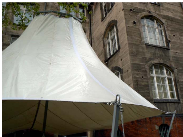
Rys. 7.21. Widok fragmentu wykonanej konstrukcji
