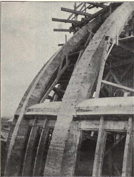
Abb. 33. Ausgeschaltete Eisenbetonrippen der Kuppel.
