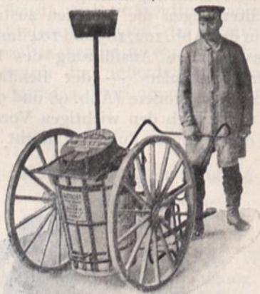
Apparat mit aufliegender Schaufel, die den Behälter hermetisch verschließt.
