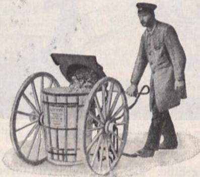
Einschütten des Kehrichts in den Behälter mittels Fußhebeldruck.
