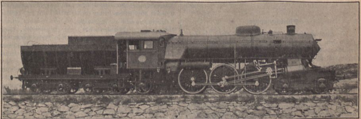
Schwedische Schnellzugslokomotive mit Kugellachsenlagerung.
