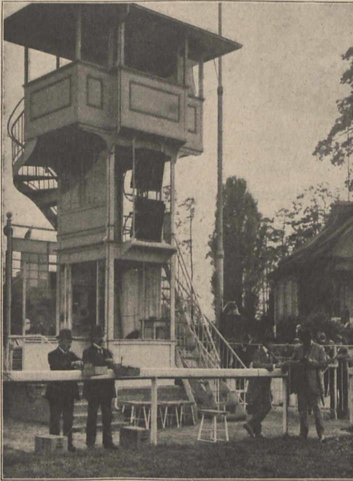
Fig. 3. Das Richterhaus auf der Rennbahn Berlin-Grünwald mit den Apparaten zur Zielphotographie im mittleren Stockwerk. Die beiden Herren unten links lösen die Apparate aus.
