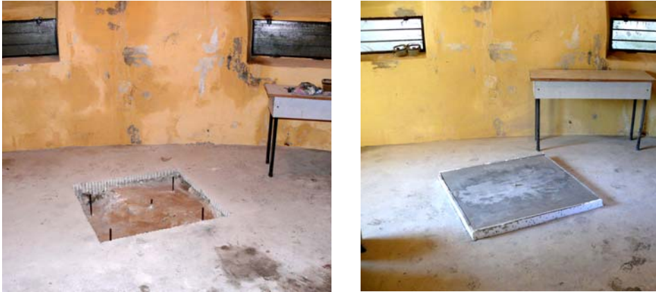
Rys. 6. Etapy stabilizacji punktu G_KAP
