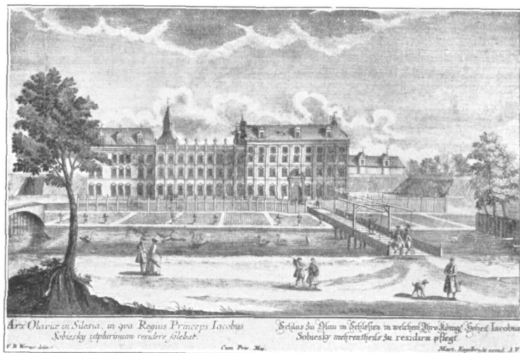
Abb. 31. Ansicht der Schloßsüdf front mit Wallgraben im Vordergrund und Wirtschaftsgebäude rechts vom Luisenbau hinter der Eckbastion. Stich von Mart. Engelbrecht nach F. B. Werners Zeichnung.
