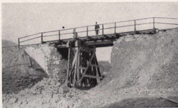
Bild 2. Wiederhergestellte Eisenbahnbrücke im Sudetenland
