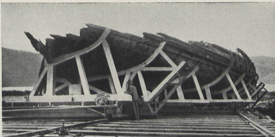
Bild 8. Der Bootskörper ruht auf einem Gerüst, in dem er auf Schienen zum Ufer befördert wird
