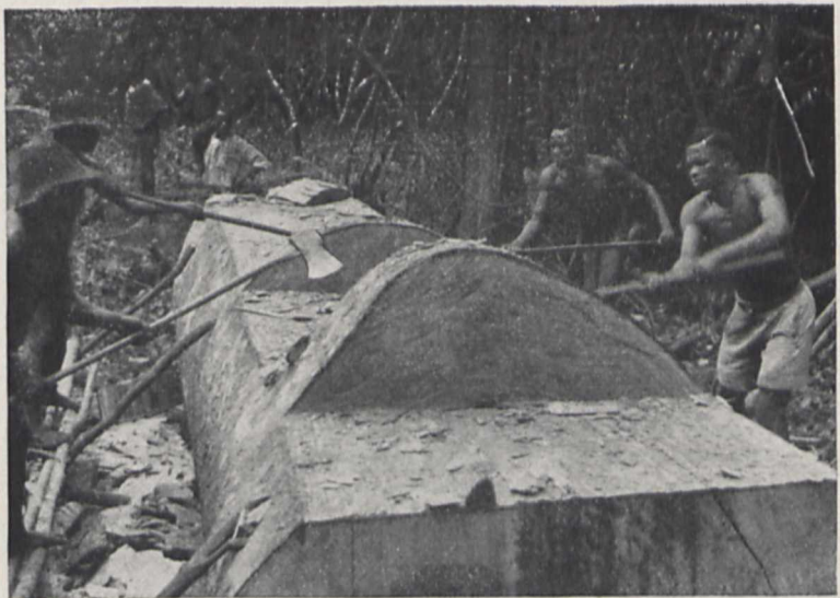
Bild 5. Vierkantbeschlagen eines Sapeli-Mahagoni-Stammes in Nigerien
