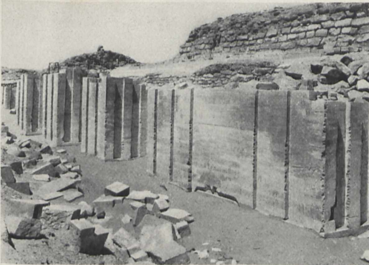
Bild 4. Umfassungsmauer des heiligen Bezirkes des Königs Zoser mit Futtermauer und feiner Kalksteinbekleidung
