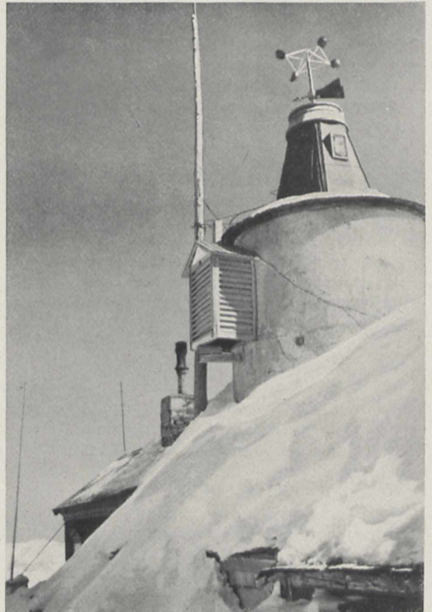
Bild 2. Der massiv gebaute Turm für Windmessungen mit Schalenkreuzanemometer, Windfahne und der an der Nordseite angebrachten Thermometerhütte
