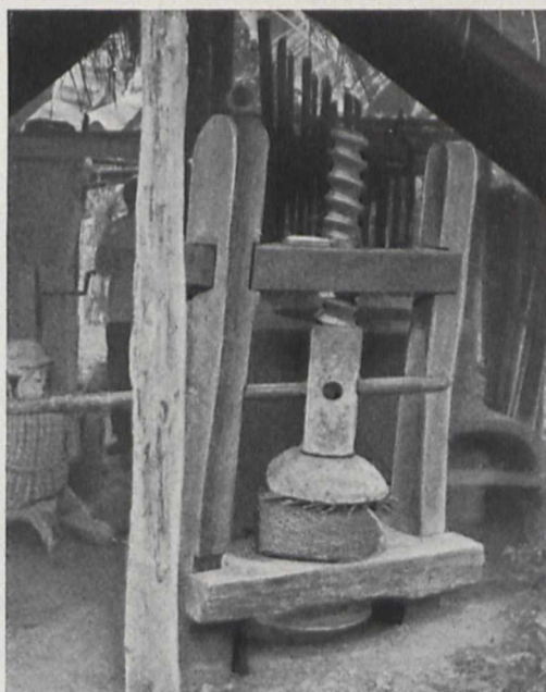
Bild 5. Mandiokaschnitzelpresse mit Tipiti (zusammendrückbarem Korb)
