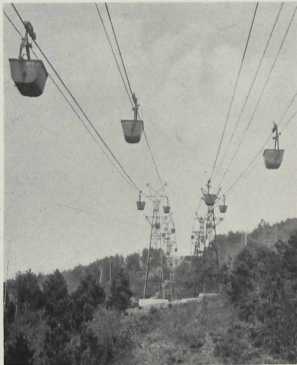
Bild 6. Doppeldrahtseilbahn von 17,5 km Länge zur Beförderung von Kohle
