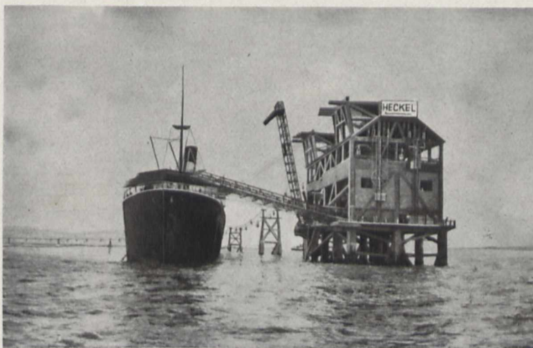
Bild 4. Be- und Entladestation einer 1,8 km langen doppelten Meeresseilbahn mit zwei Bandauslegern zum Verladen des Fördergutes. Stundenleistung je Bahn 150 t, Tragseil-Spannweite 220 m, Stützhöhe bis zu 16 m über dem Wasserspiegel
