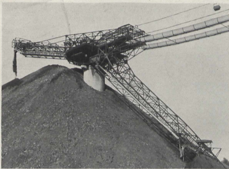
Bild 7. Auf 36 m hoher Betonsäule ruhende Entladestation einer Drahtseilbahn für Haldenanschüttung mit im Winkel von 180° schwenkbarem Ausleger, durch dessen Vortrieb ein Gelände größten Ausmaßes überschüttet werden kann
