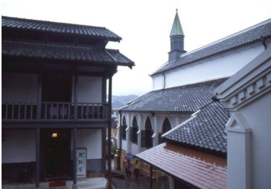
Fot. 71: Budynek dawnego seminarium w Nagasaki.
