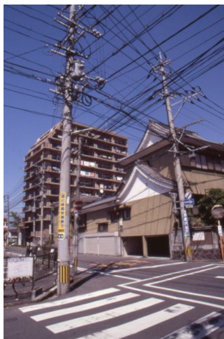
Fot. 81: Napowietrze instalacje elektryczne w Oita (częsty widok w całej Japonii).
