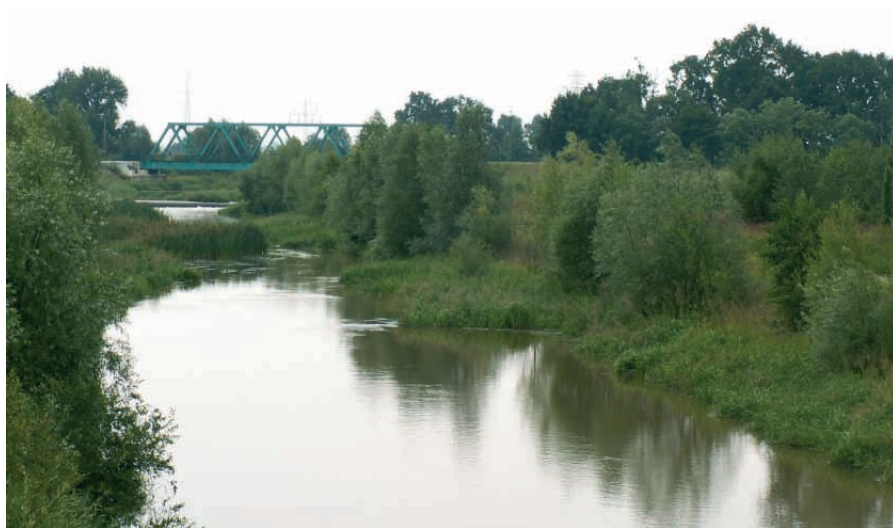
Most kolejowy na rzece Oławie w Siechnicach
