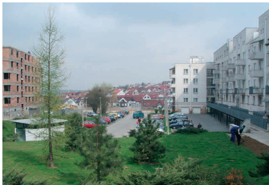
Zielen ochronna przy parkingu nowej części osiedla Mistrzejowice w Krakowie
