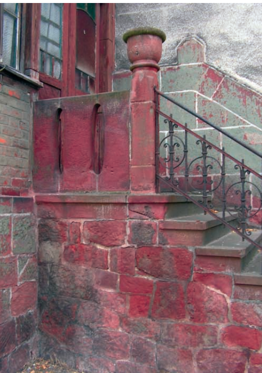
Kamienne schody przy ul. Kłodzkiej 9 (Słupiec)
