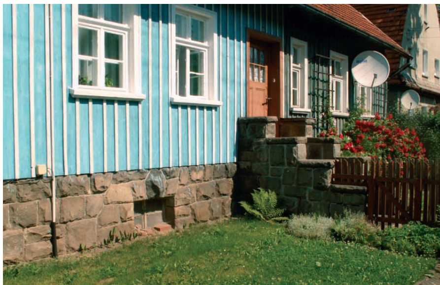
Piaskowcowa podmurówka i schody
