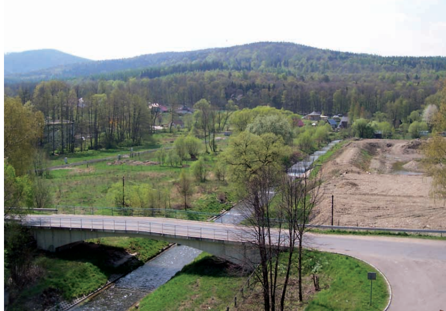
Widok z mostu nad Złotym Potokiem w kierunku południowym
