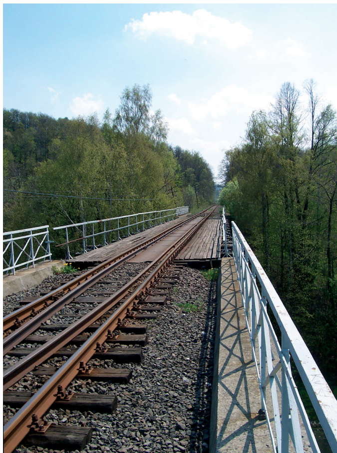
Widok wzdłuż toru na moście kolejowym w Moszczance
