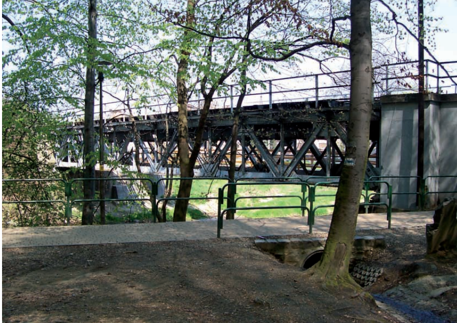
Ażurowa konstrukcja mostu nad Białą Głuchołaską
