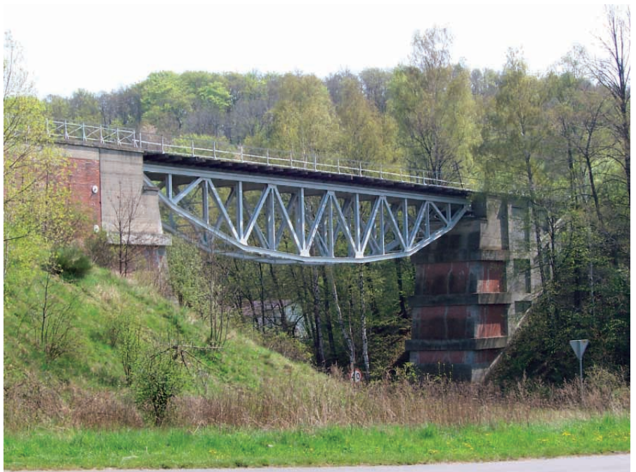
Most kolejowy nad Złotym Potokiem w Moszczance
