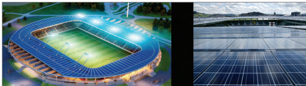
Rys. 6. „Słoneczna tarcza” z ogniwami fotowoltaicznymi na dachu stadionu w St. Paten, fot. agn Group
