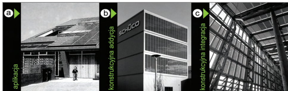
Rys. 2. Przykłady stopni integracji aktywnych paneli solarnych: a) aplikacja, b) addycja, c) integracja, fot. P. Kuczia
