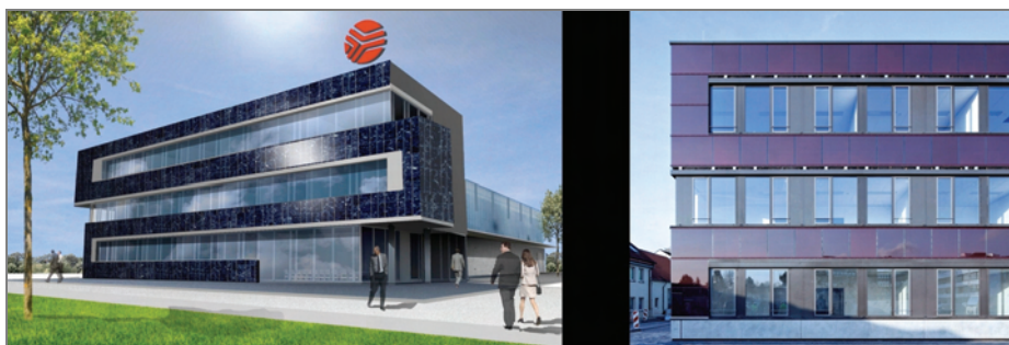
Rys. 7. Solarna fasada budynku biurowego Stadtwerke w Osnabrück, fot. agn Group
