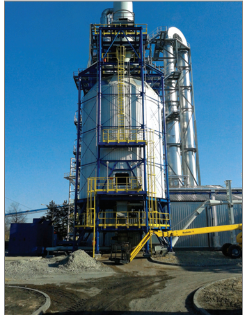
Rys. 6. Przykład współczesnego rozwiązania konstrukcyjnego stalowego silosu na biomase, fot. J. Rządkowski
