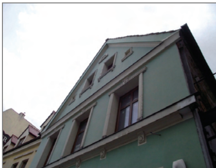
Rys. 1. Przykład zewnętrznej termomodernizacji: kamienica w trakcie termomodernizacji „od zewnątrz”, odnowa elewacji wraz z odtworzeniem elewacji i jej elementów dekoracyjnych; Żary, ul. B. Chrobrego, woj. Lubuskie 2012, fot. A. Brzezicka
