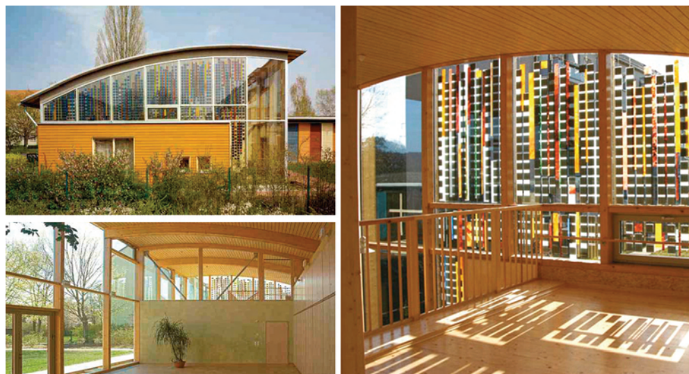
Rys. 3. Przedszkole Katolickie w Dreźnie, Architektengemeinschaft Reiter und Rentzsch: a) budynek z zewnątrz, b) wnętrze, c) szkło laminowane [14]
