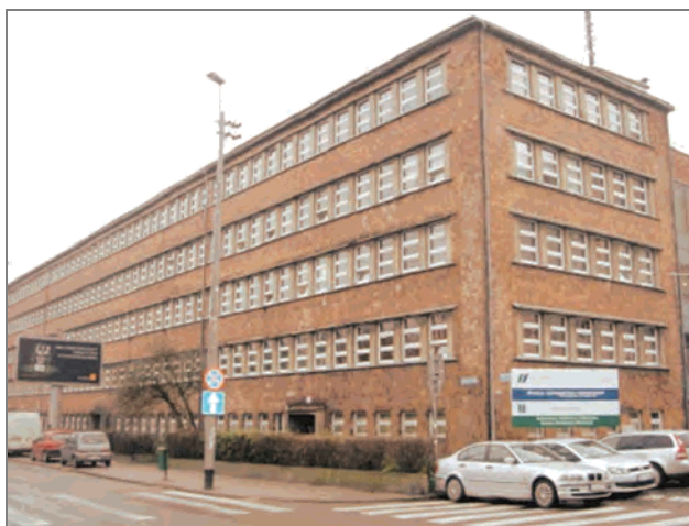
Rys. 1. Widok skrzydła zachodniego budynku WBIA ZUT w Szczecinie, fot. A. Swarczewicz
