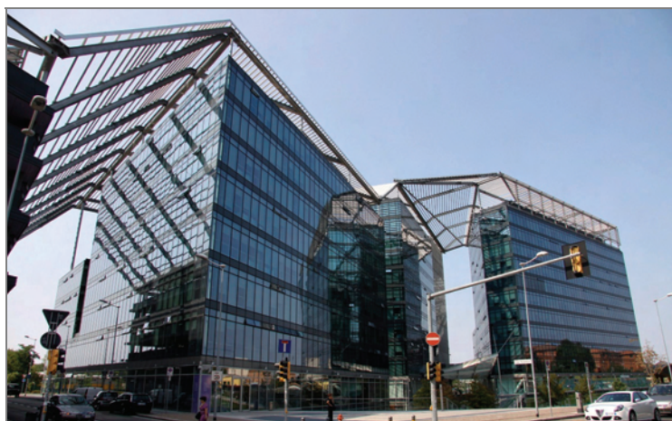
Rys. 1. Siedziba Rady Miejskiej w Bolonii (2008), projekt: Mario Cucinella Architects. Nowy obiekt zastąpił funkcjonalnie 21 budowli, rozrzuconych w różnych częściach miasta. Budynek jest dobrze połączony z siecią komunikacyjną, zaś decyzja o jego lokalizacji wpłynęła na poprawę standardu dzielnicy Bolognina, fot. B. Widera
