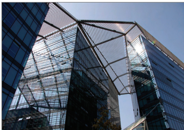
Rys. 4. Siedziba Rady Miejskiej w Bolonii (2008), projekt: Mario Cucinella Architects. Fragment elewacji i szklanego zadaszenia, chroniącego przed nadmierną insolacją i spajającego trzy części obiektu w jedną całość. Uniesienie osłony przeciwsłonecznej ponad tarasem panoramicznym wymusza przepływ powietrza i poprawia wentylację całego budynku. Fot. B. Widera
