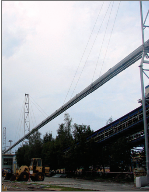
Rys. 5. Wielocięgnowa konstrukcja wieszarowa typowego przenośnika tubulatorowego biomasy, fot. J. Rządkowski
