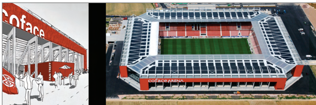
Rys. 5. Ogniwa fotowoltaiczne na dachu stadionu w Moguncji, fot. agn Group
