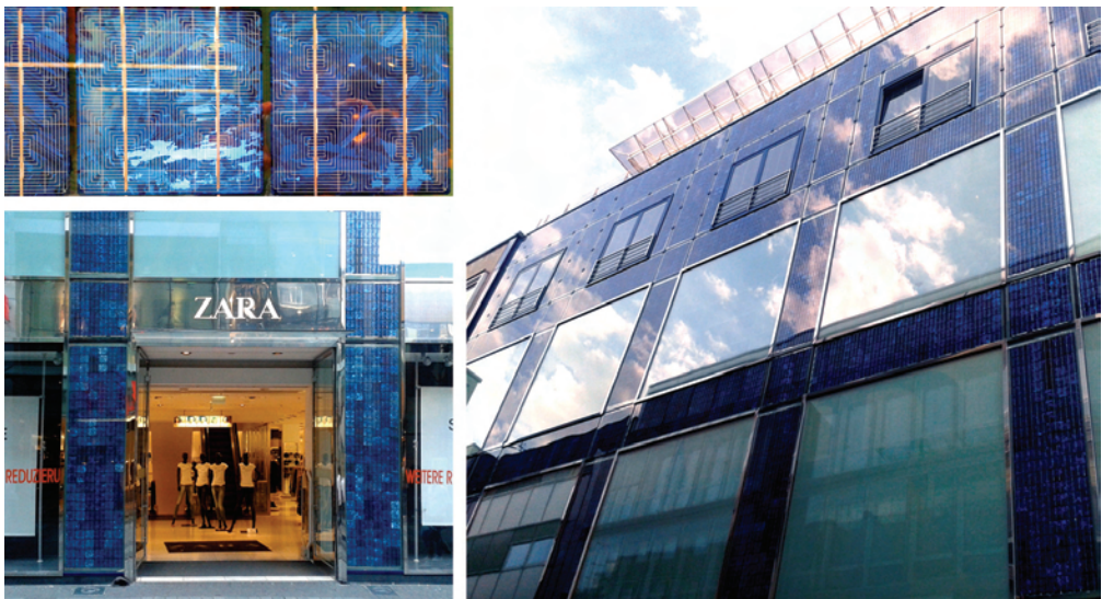
Rys. 2. Budynek firmy ZARA w Kolonii: a) polikrystaliczne ogniw krzemowe, b) okładzina ścienna, c) fasada wentylowana, fot. A. Budzyńska
