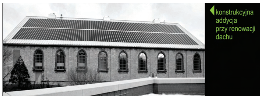
Rys. 3. Integracja ogniw fotowoltaicznych w przypadku renowacji, fot. P. Kuczia
