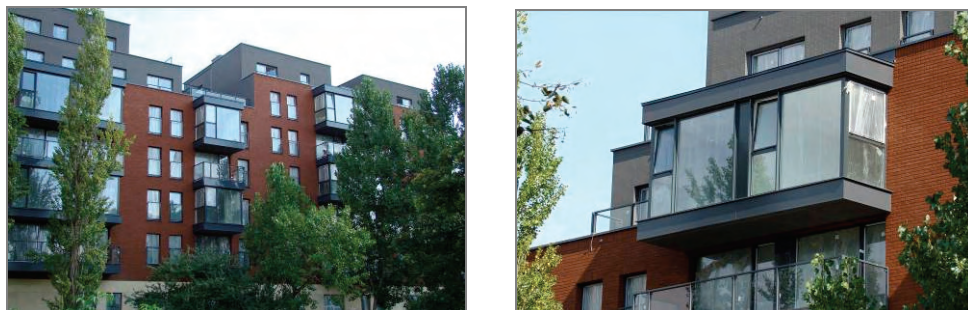
Rys. 4. Zabudowa loggii w nowo wybudowanym budynku wielorodzinnym. Gdańsk, fot. J. Biedrońska
