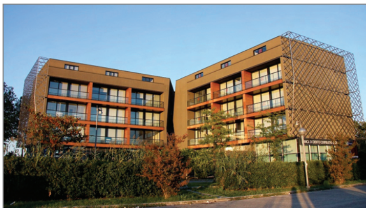
Rys. 6. Siedziba Starostwa Powiatowego Forum w Rimini, projekt: Mario Cucinella Architects (2007). Symetryczne skrzydła budynku oddzielają nowo utworzony skwer od skrzyżowania. Konstrukcję wertykalnego ogrodu tworzy siatka kwadratów, o boku 60 × 60 cm, wykonana ze stali nierdzewnej. Fot. B. Widera
