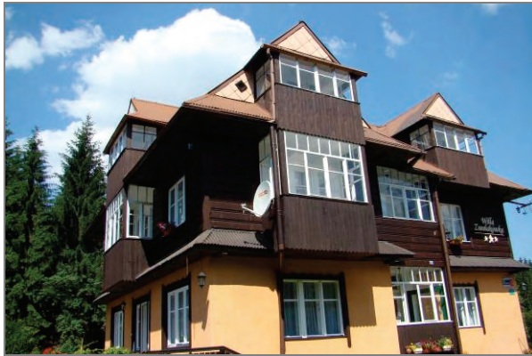
Rys. 3. Przestrzeń buforowa w tradycyjnym budynku góralskim w postaci zadaszonych werand. Istebna, fot. J. Biedrońska
