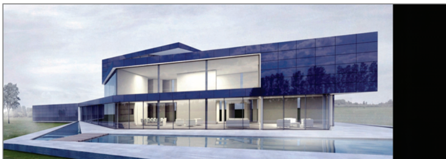
Rys. 8. Panele solarne na fasadzie samowystarczальной willi plus-energetycznej, oprac. własne
