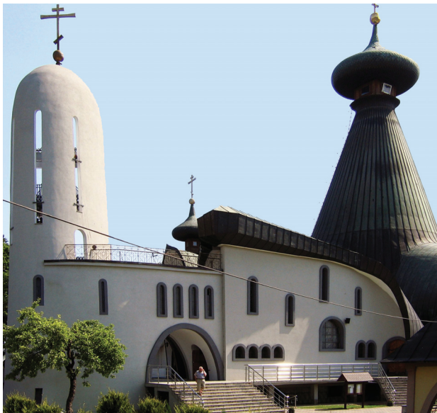
Il. 6A. Cerkiew Świętej Trójcy w Hajnówce. Okna elewacji (fot. K. Woźniak)
