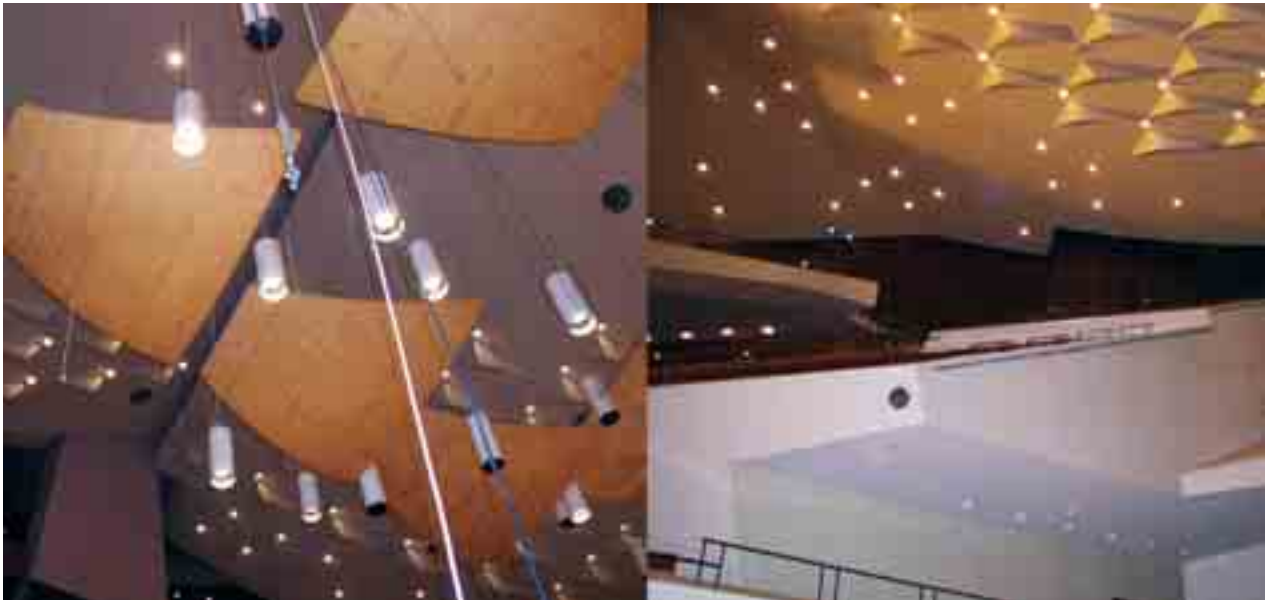
Il. 8. Wnętrze sali głównej: a) ustrój akustyczny nad sceną, b) ukształtowanie górnych tarasów Fig. 8. Interior of the main hall: a) acoustic structure above the scene, b) upper terraces formation
