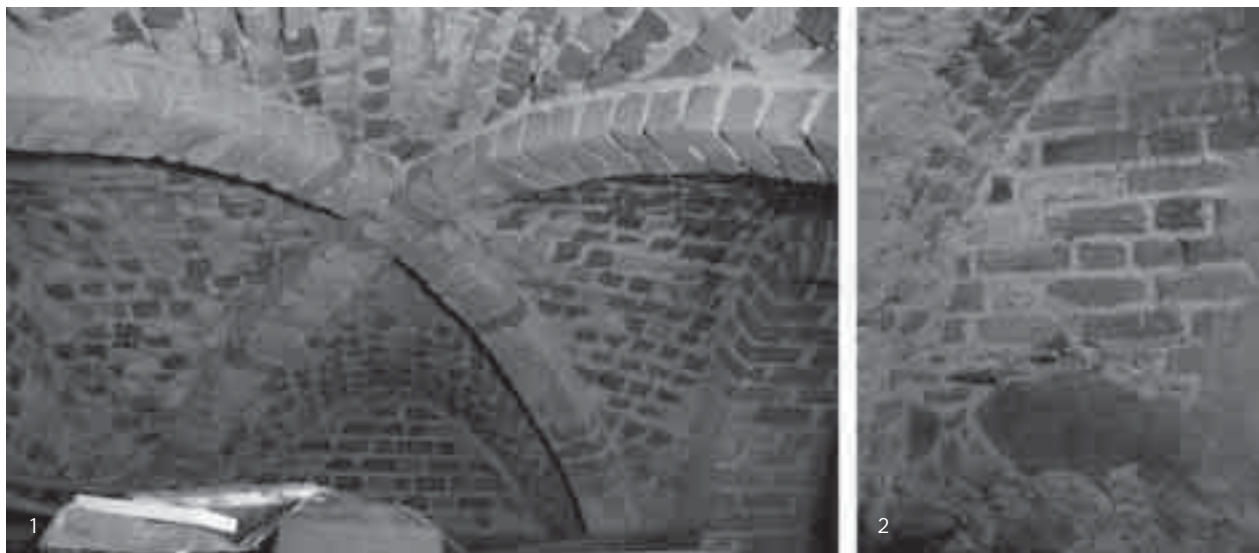
Il. 10. Środkowa część piwnicy południowej: 1 – sklepienie, 2 – ściana południowa, 2007 r.
