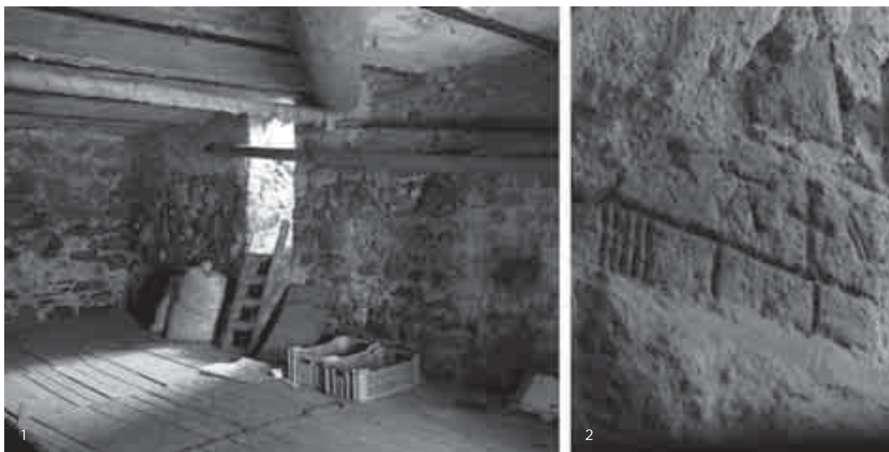
Il. 11. Piwnica w południowo-wschodnim narożniku klauzury: 1 – wnętrze, 2 – ryt na cegle w glicie okiennym, 2007 r.
