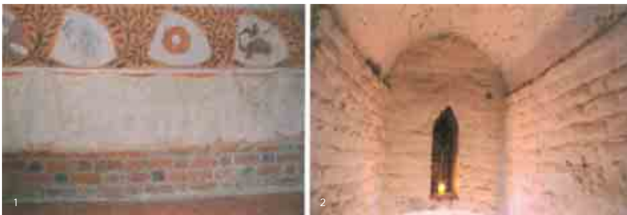
Il. 14. Wschodnie skrzydło klauzury: 1 – ściana południowa kaplicy św. Jakuba, 2 – okienko w ścianie zachodniej klatki schodowej, 2007 r.
