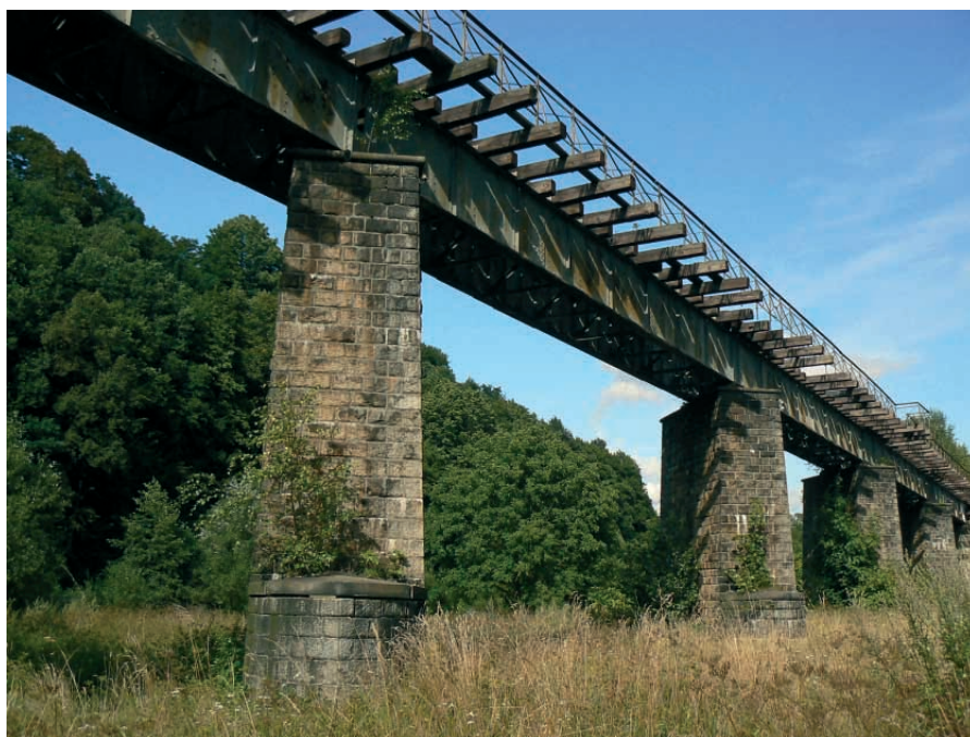
Ryc. 6. Wiadukt w Lubachowie na 67,126 km trasy (fot. E. Podgórska, 2008)
