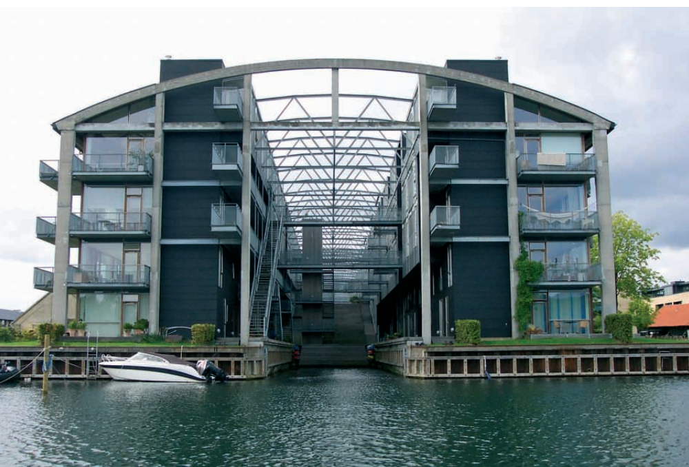
Ryc. 2. Widok na zabudowę mieszkaniową usytuowaną nad kanałem
