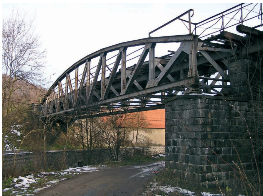
Ryc. 8. Wiadukt w Jugowicach na 72,860 km trasy (fot. J. Gubański, 2007)
