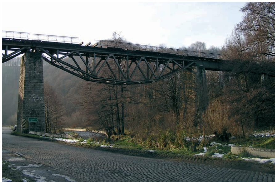
Ryc. 7. Wiadukt w Lubachowie na 67,529 km trasy (fot. J. Gubański, 2007)
